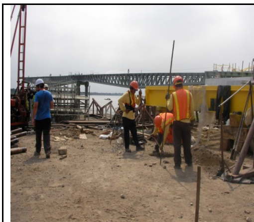
Foto de Perforación en P5
