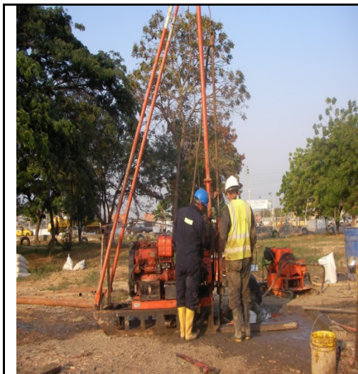
Foto de Perforación en P10
