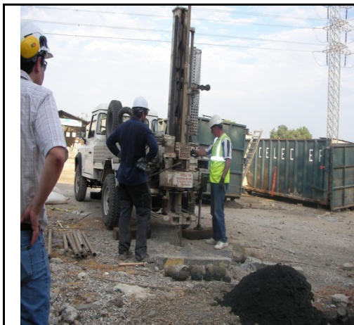
Foto de Perforación en P9
