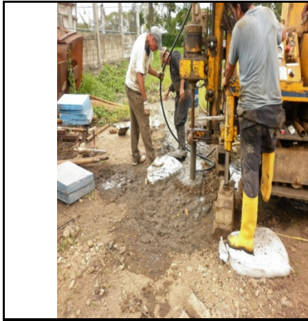
Foto de Perforación en P7
