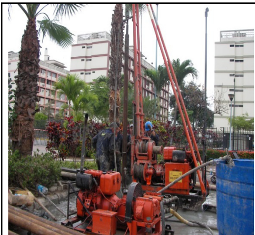
Foto de Perforación en P4
