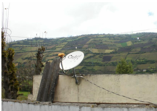
Figura 8. Antena DTH para televisión satelital en Matus
