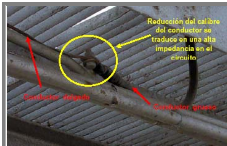
Figura 2.37 Múltiples conexiones a un mismo punto
