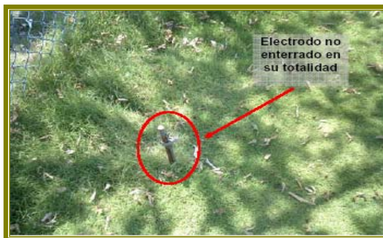
Figura 2.43 Electrodo no enterrado en su totalidad
