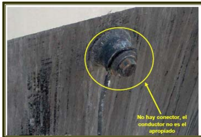
Figura 2.21 No hay conector.
