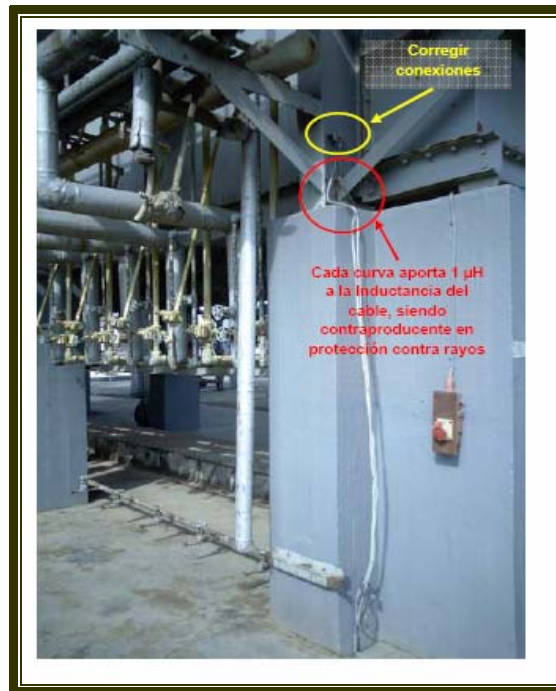
Figura 2.19 Conectores oxidados no garantizan un buen contacto
