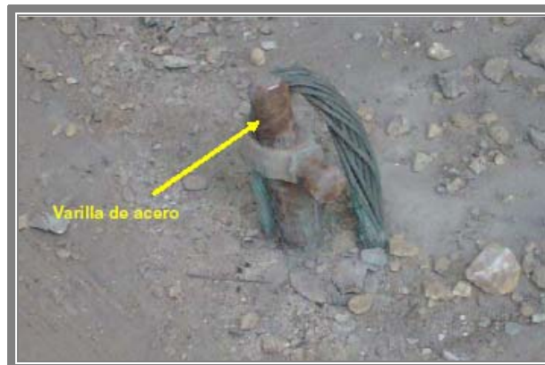
Figura 2.40 Múltiples conexiones a un mismo punto.
