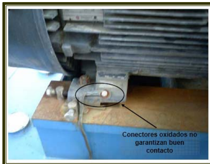
Figura 2.20 Conectores oxidados
