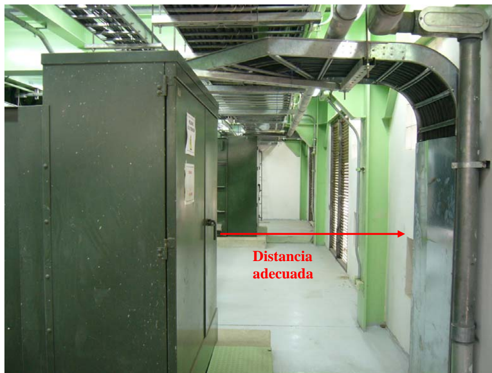
Figura 5.8 Distancia entre pared y transformadores
