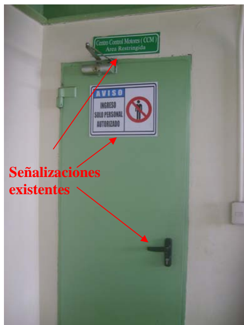
Figura 6.3 Puerta de acceso al CCM
