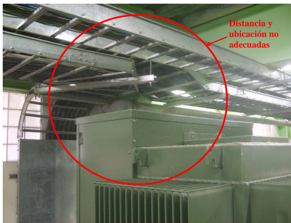
Figura 5.9 Distancia entre bandeja y transformador
