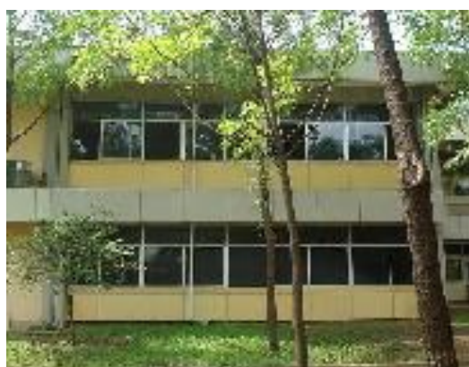
Figura 4-11 Bloques de Aulas de la FIEC
