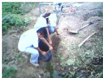
Colocación de tanque para medición de caudal
