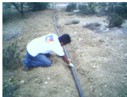
Colocación de tubería
