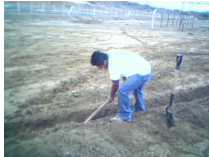
Zanja para manguera
