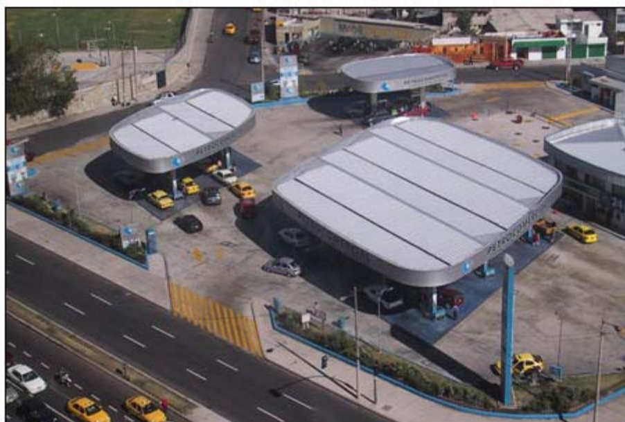
Figura 3-8: Estación uio de Petrocomercial.
