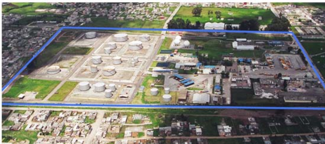
Figura 3-4: Terminal de productos limpios el beaterio de Petrocomercial.
