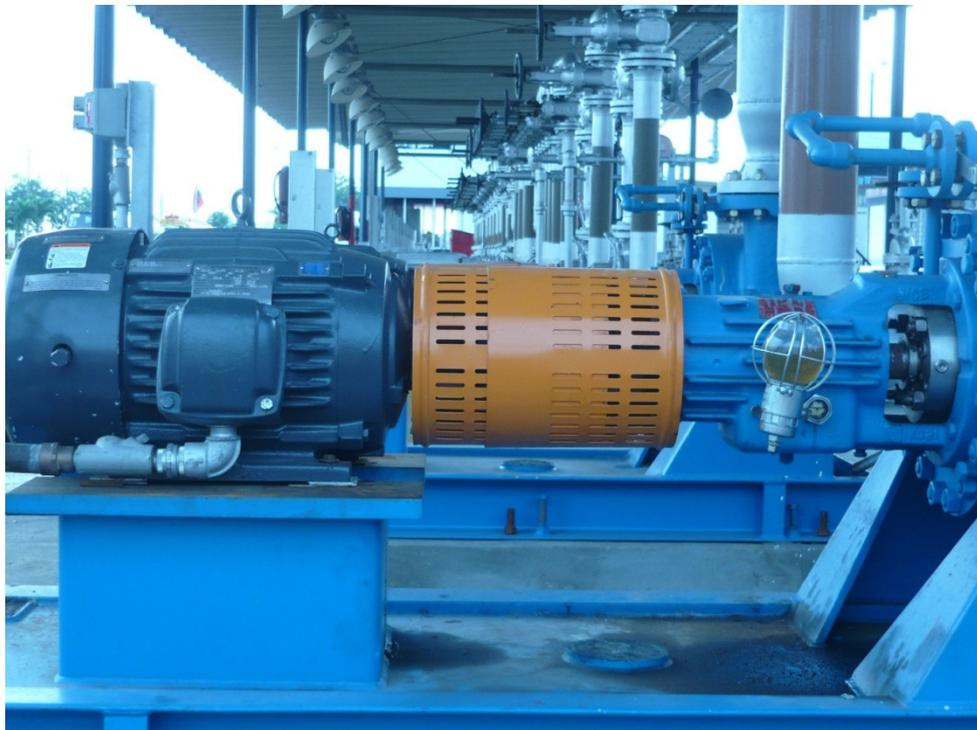
**Figura 2-2. Motor y bomba acoplada a un eje**
