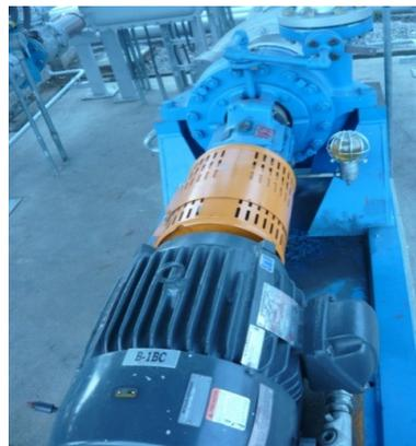
**Figura 4-27. Bomba centrífuga horizontal**
