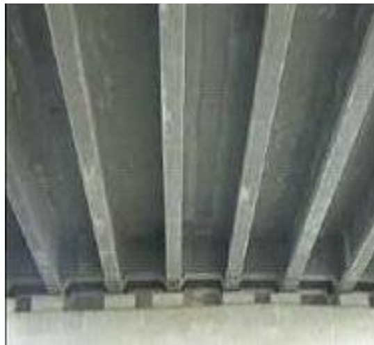
FIGURAS 2 Y 3. Puente Bourg-les-Valence primer puente vehicular con HUAD del mundo, Francia. Vigas principales pre-esforzadas.
