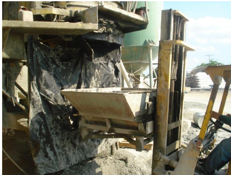
FIGURA 24. Vertido de la mezcla en un montacargas adaptado para transportar hormigón.
