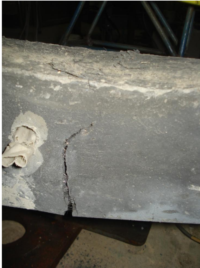
FIGURA 37. Detalle de fisura en la zona de falla de la viga construida con HAD (vista posterior).
