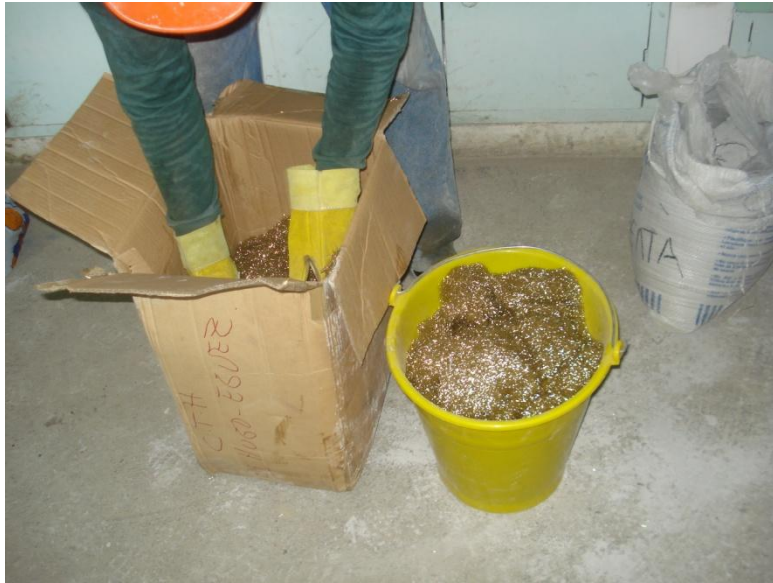
FIGURA 20. Dosificación de los materiales. Pesado de las fibras metálicas.
