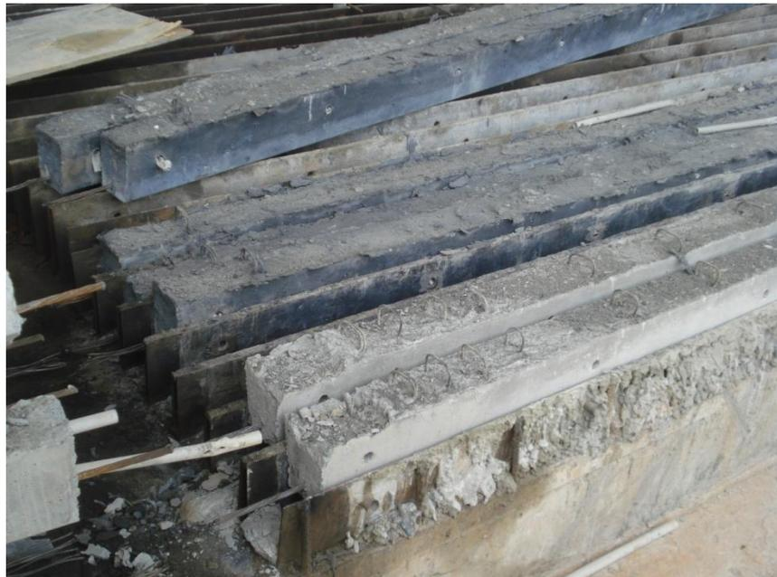
**FIGURA 26.** Desmolde de las viguetas. Izquierda, HAD. Derecha hormigón convencional.
