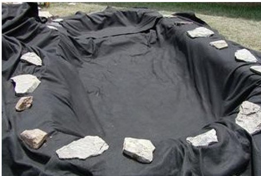
**FIGURA 3.36. Tolda para cubrir la superficie de las piscinas de oxigenación.**
