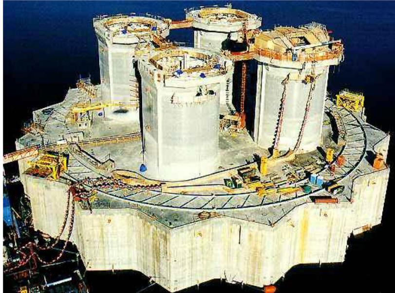
**Fig. 3.5 Base estructural de la Plataforma Hibernia parcialmente sumergida**
