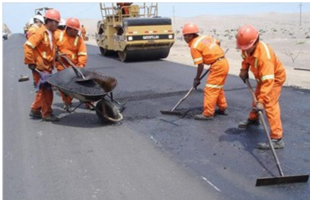
Rastrillado, corrección y rodillado
