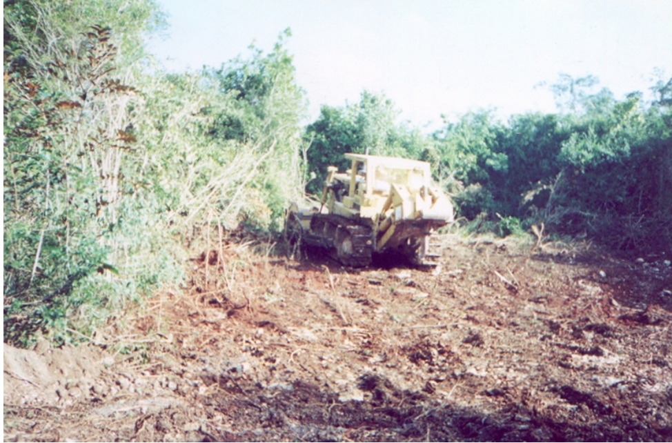
Desbroce de ancho de vía
