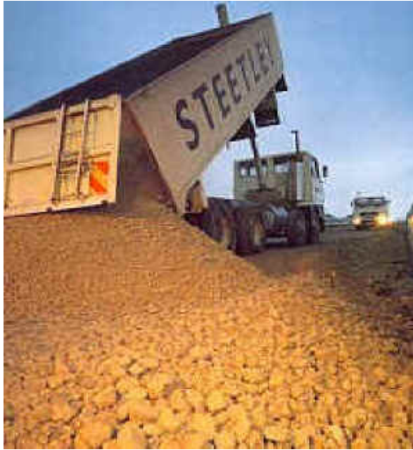
Estoqueo de material (sub-base o base)
