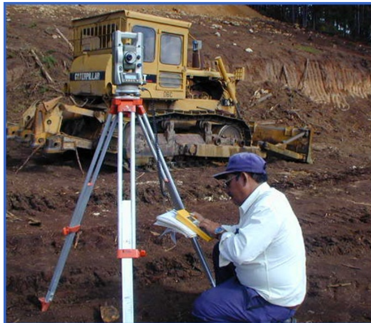
Fig. 3.6 Control in situ de cotas de subrasante Fuente: Perfiles Transversales
