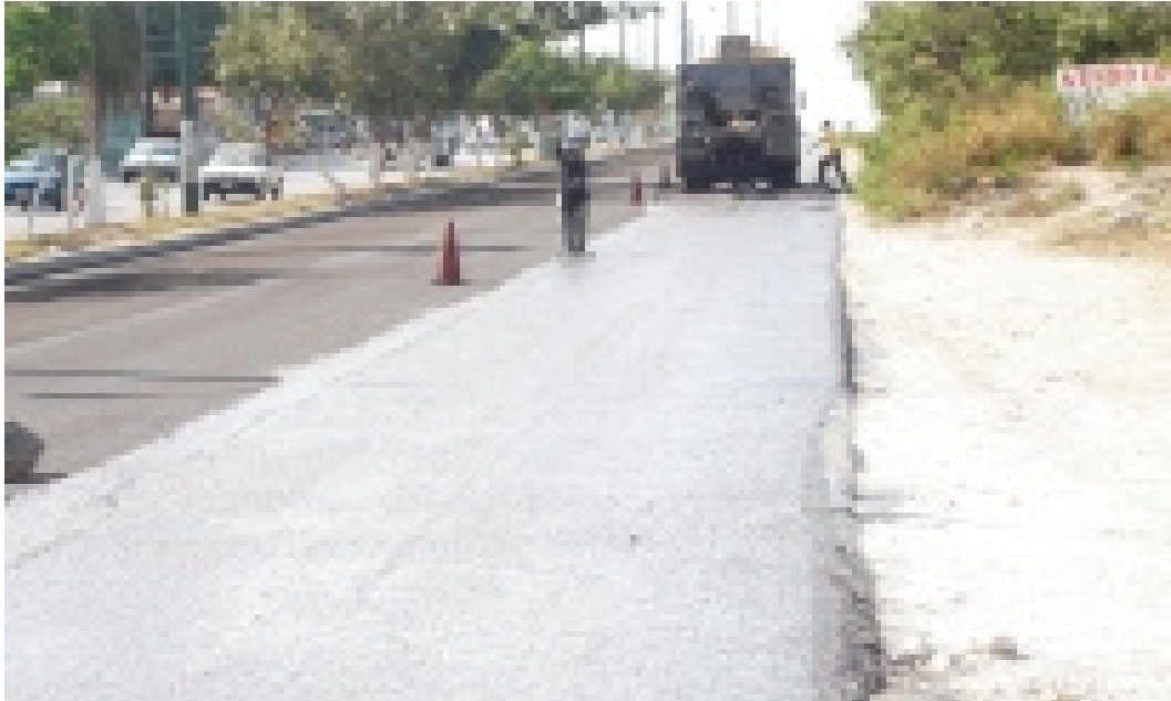
Imprimación con tanquero esparcidor
