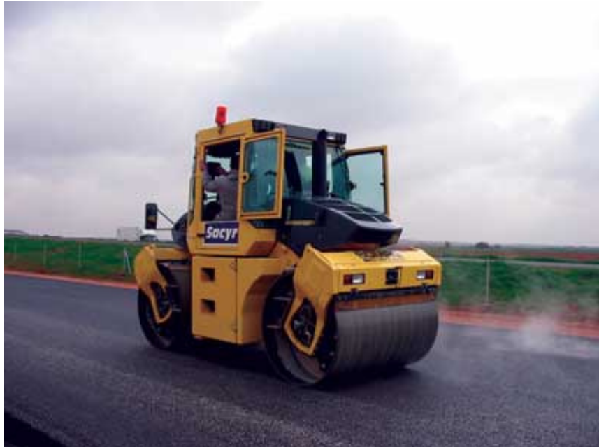
Compactación de carpeta asfáltica con rodillo tambor
