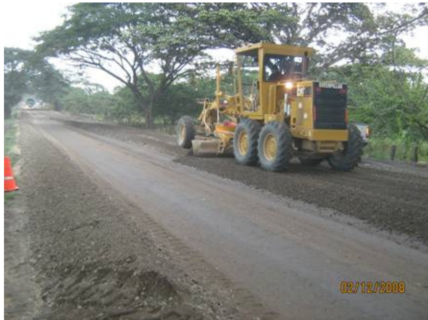
Nivelación del material estoqueado por motoniveladora
