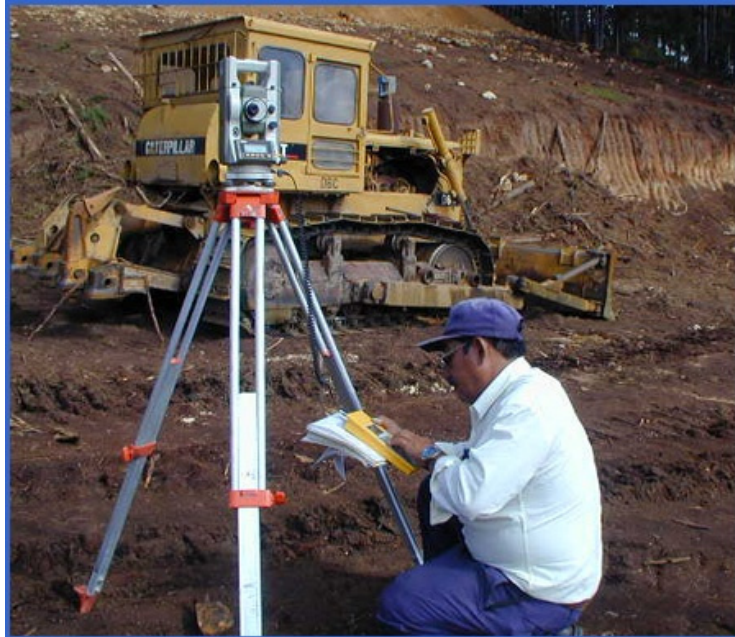
Ing. Residente (Chequeo de movimiento de tierra)
