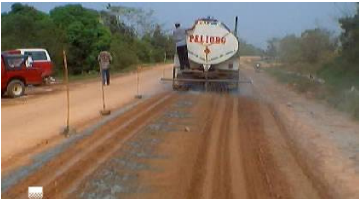
Hidratación con tanquero (humedad optima)
