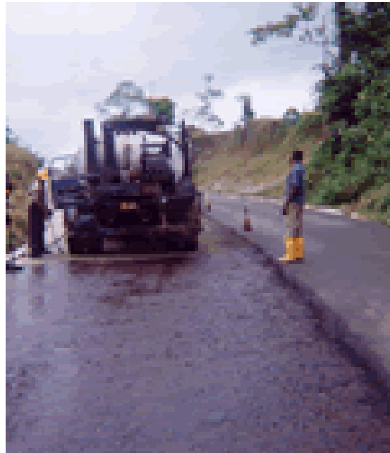
Imprimación con tanquero esparcidor
