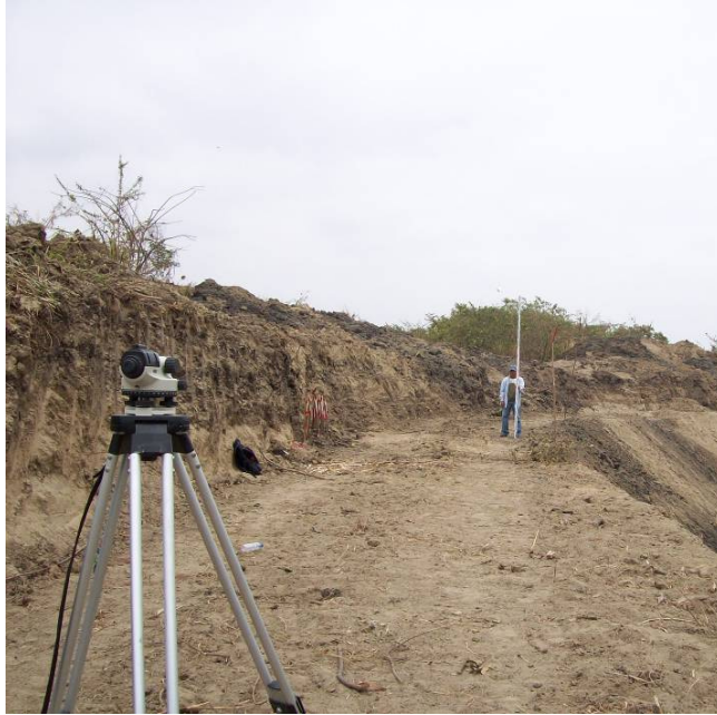
Colocación de Balizas
