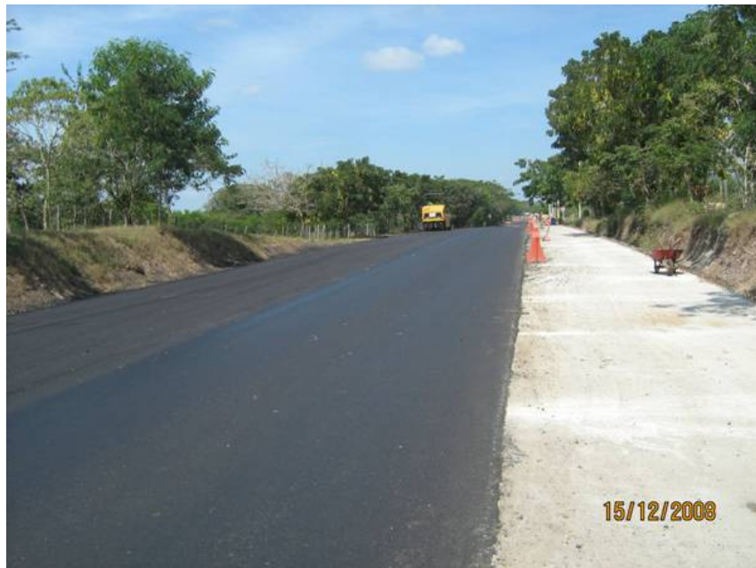
Carpeta asfáltica terminada
