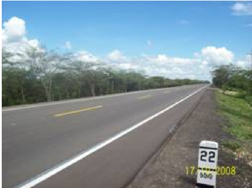
Vía culminada (Señalética horizontal y Vertical)
