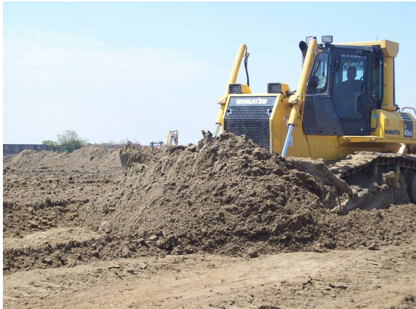
Sección de Relleno con tractor
