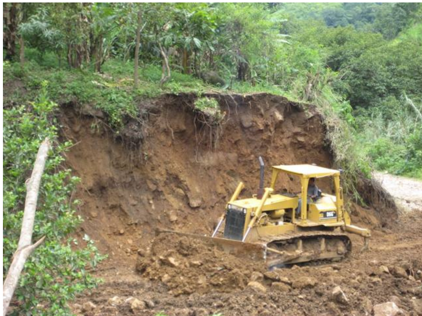
Sección de Corte con tractor
