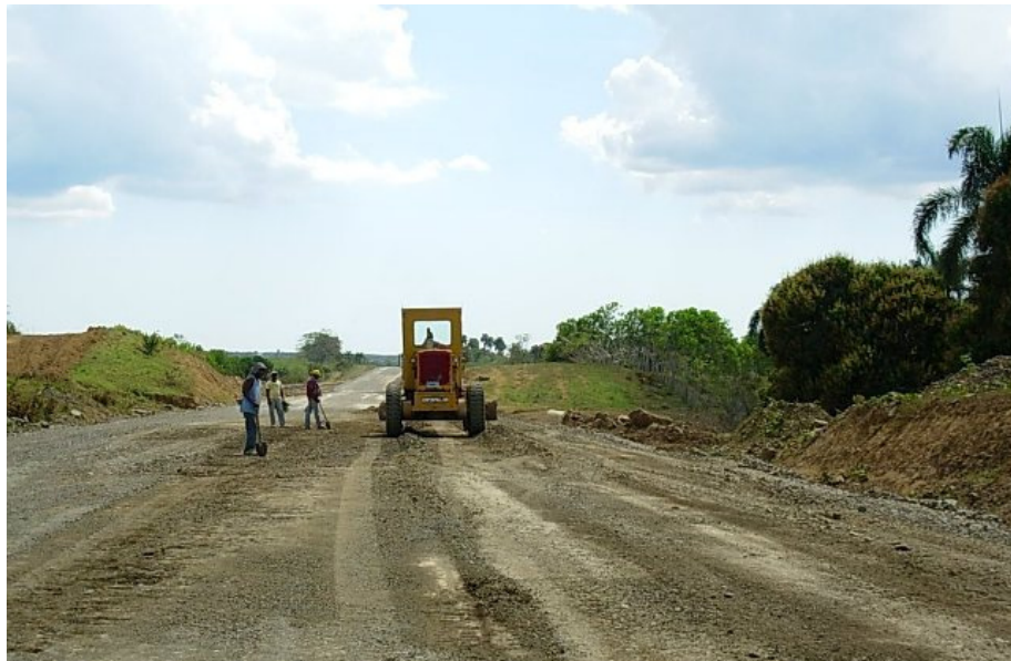
Fig. 4.4 Nivelación de ultima capa de subbase Fuente: Internet
