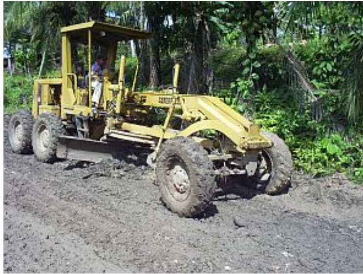
Nivelación del material estoqueado por motoniveladora
