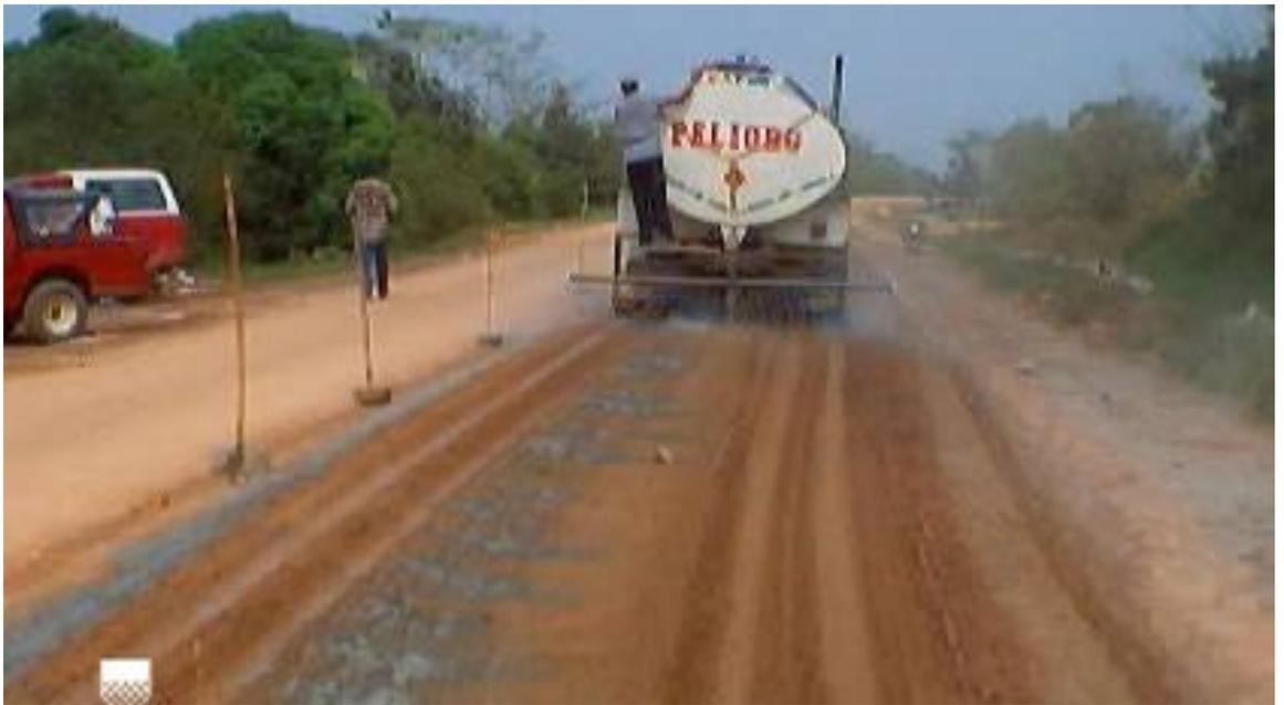
Hidratación con tanquero (humedad optima)
