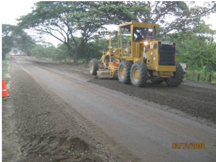
Nivelación del material estoqueado por motoniveladora
