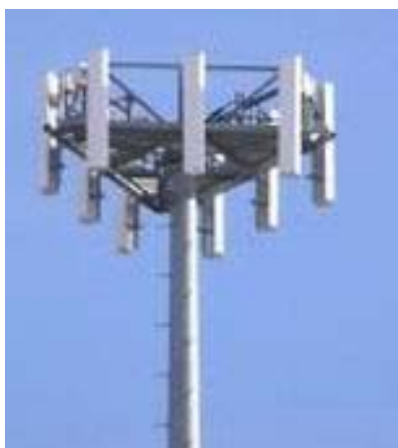
Gráfico 3.6. Torre de transmisión de telefonía celular
