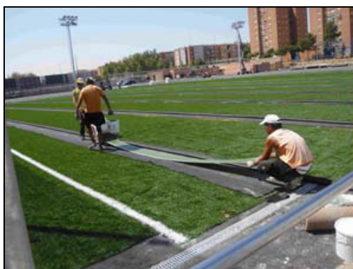
Figura N° 2.36 Unión de rollos de césped sintético
