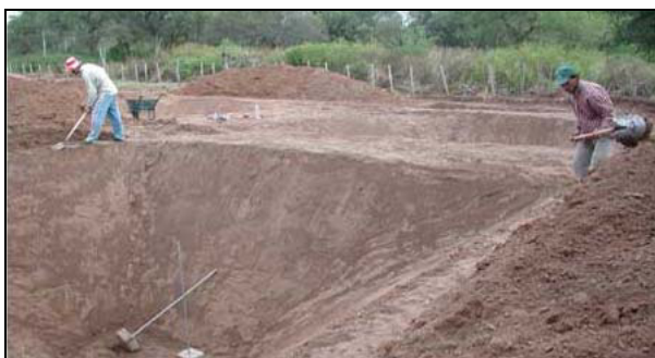
Figura N° 2.30 Excavación del terreno para canchas sintéticas
