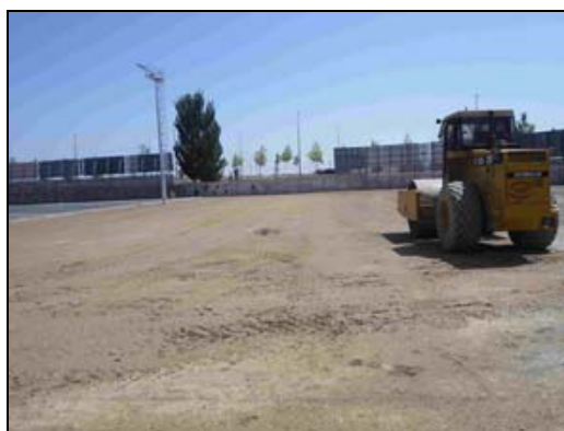
Figura N° 2.31 Compactación del terreno para canchas sintéticas
