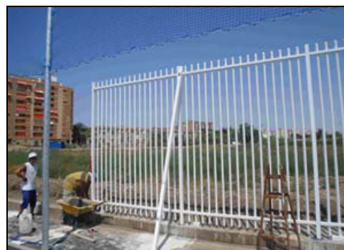
Figura N° 2.43 Cerramiento con malla metálica
