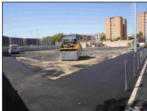
Figura N° 2.34 Asfaltado de terreno para cancha sintética
