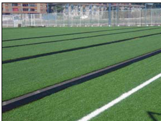
Figura N° 2.35 Tendido de rollos de césped sintético
