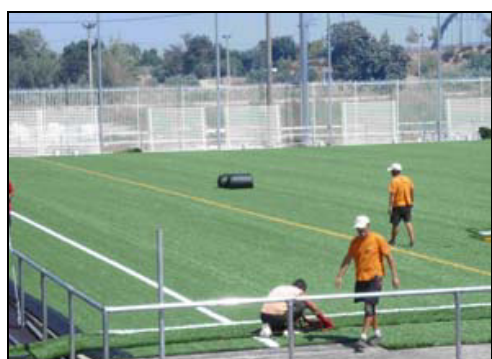
Figura N° 2.37 Colocación de líneas
