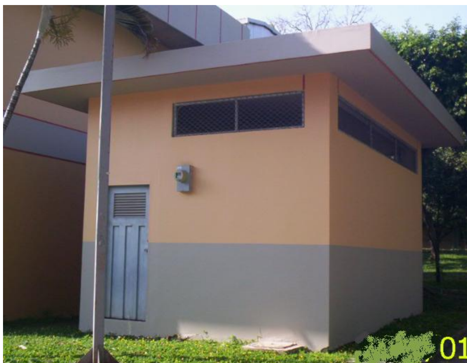
Figura 5. Vista exterior en subestación eléctrica “C/T 23”.
