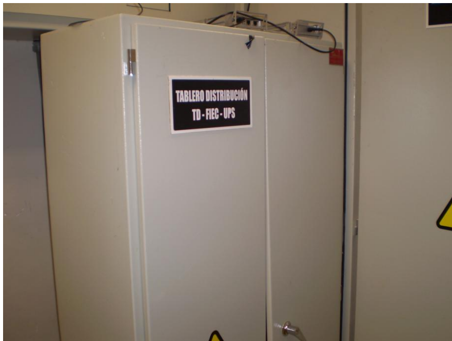
Figura 16. Tablero de distribución de subestación eléctrica tipo “Padmounted”.
