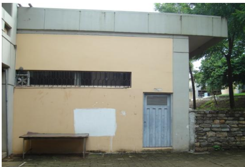
Figura 7. Vista exterior de subestación eléctrica “C/T 22”.
