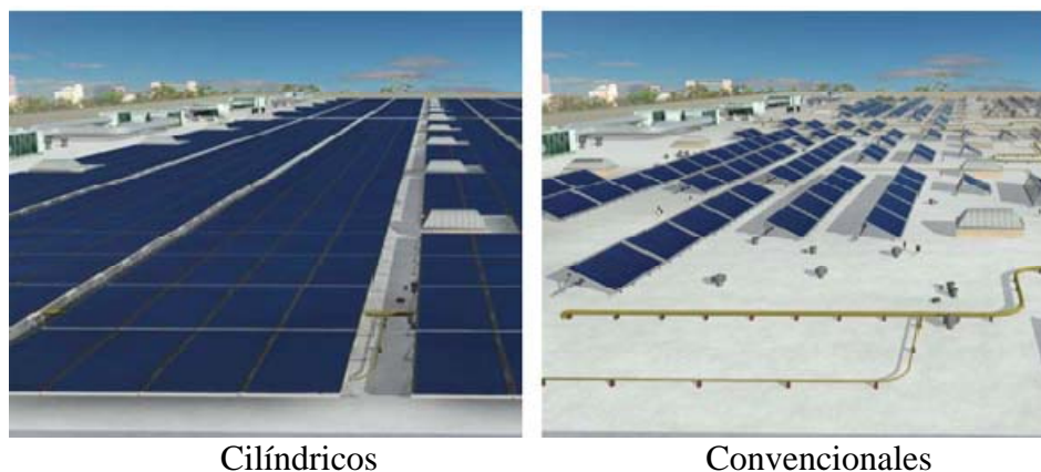
Figura 3.24. Comparación entre colocación de paneles cilíndricos y convencionales
