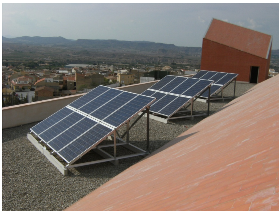
Figura 2.7. Instalación fotovoltaica en el tejado
