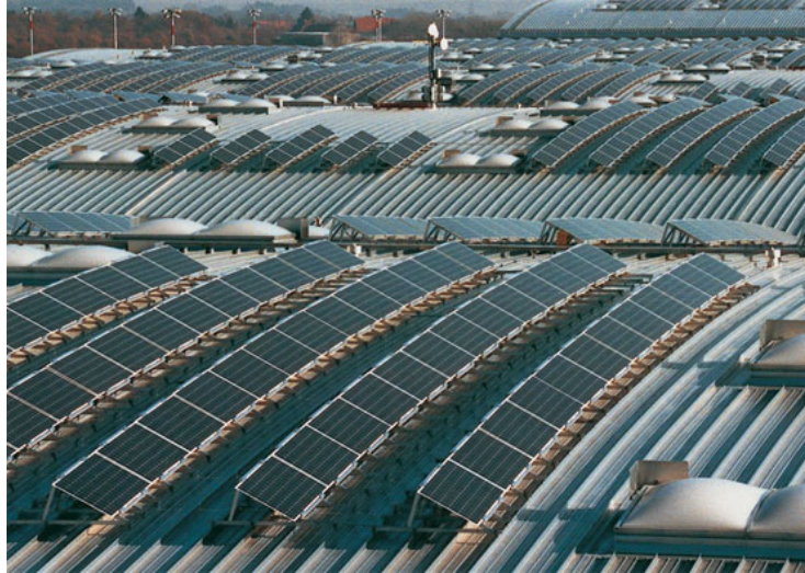
Figura 1.12. Instalación Fotovoltaica en tejado.
