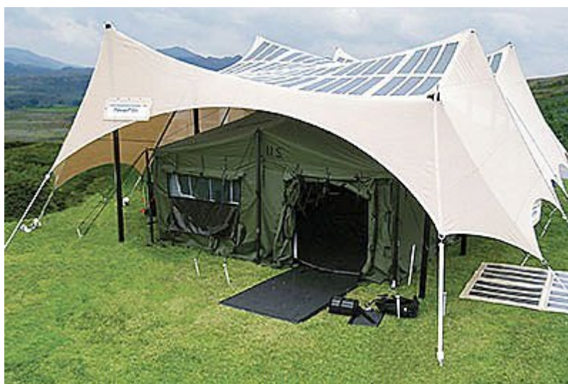
Figura 1.11. Instalación Fotovoltaica en carpas
