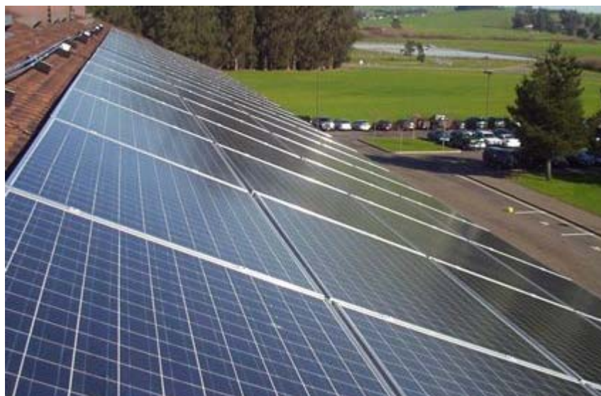
Figura 3.18. Instalación de paneles de Silicón Multicristalino en el tejado
