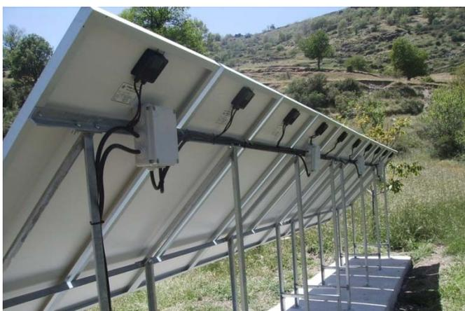
Figura 3.34. Estructura y Soportes para los Módulos Fotovoltaicos
