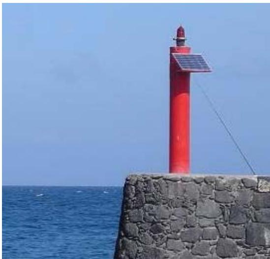
Figura 2.1. Instalación fotovoltaica en faros
