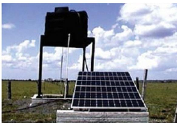
Figura 4.9. Sistema de Bombeo de Agua por Sistema Fotovoltaico
