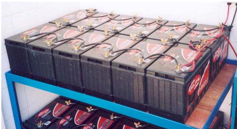
Figura 3.29. Banco de Baterías para sistemas Fotovoltaicos
