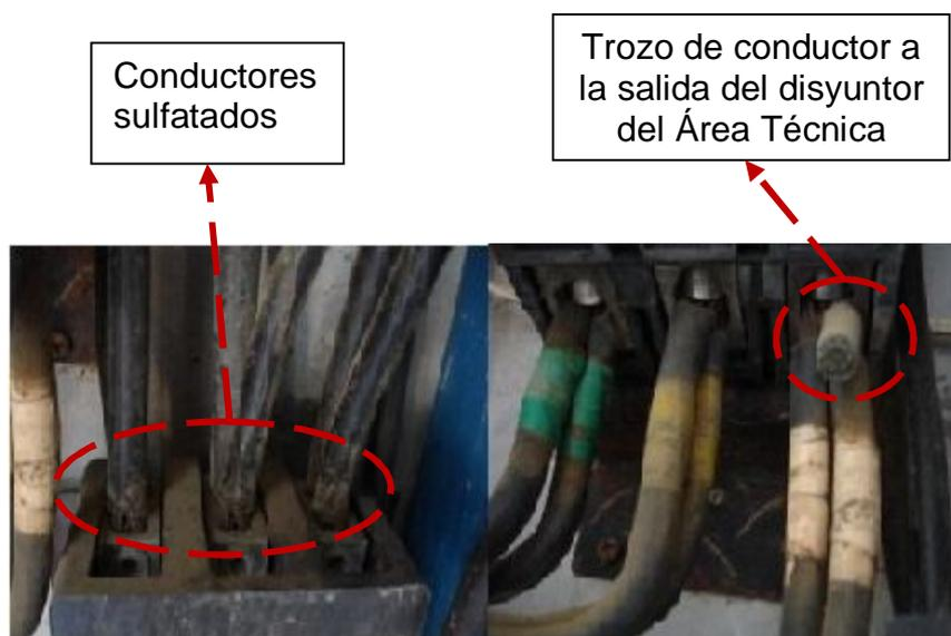
**Figura 3.9 Disyuntores de Planificación y Área Técnica**
