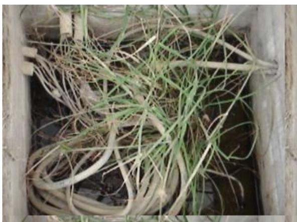
**Figura 3.11 Conductores en contacto con el agua y maleza**
