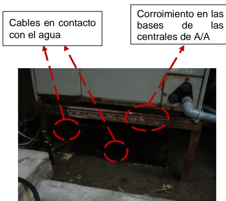
**Figura 3.12 Centrales de Aire Acondicionado – Recaudaciones**
