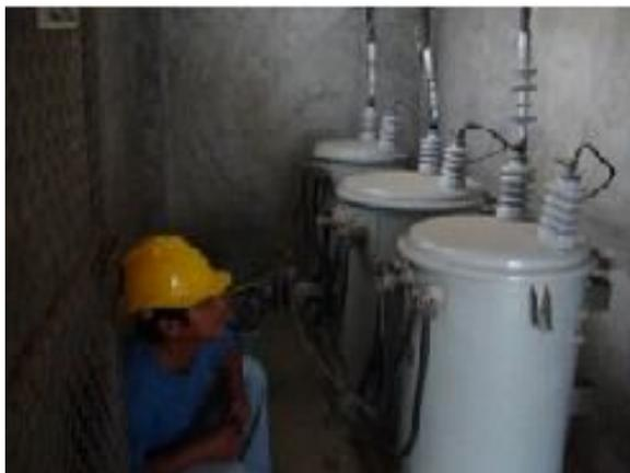
**Figura 3.10 Toma de datos en la placa de los transformadores**
