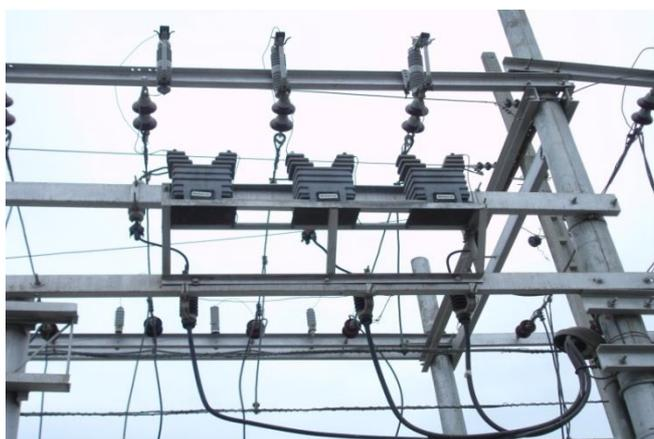
**Figura 3.2 Alimentadores desde el pórtico de 13,8 kV al banco de transformadores.**
