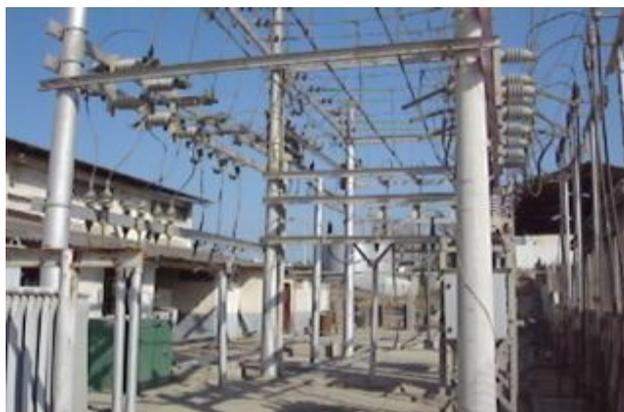
**Figura 3.1 Vista de pórtico de 13.8 kV**
