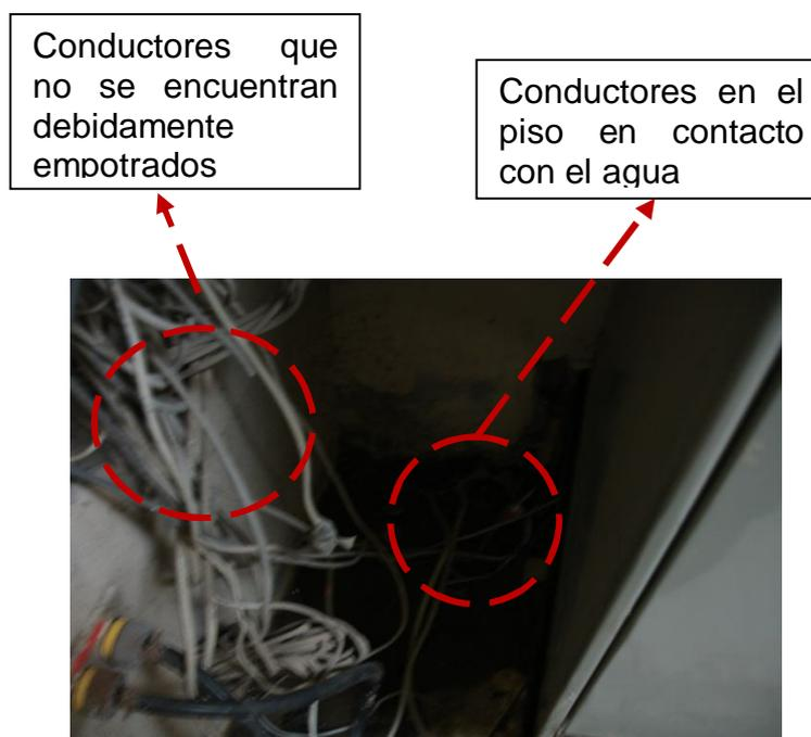
**Figura 3.13 Disposición de conductores Área de Recaudaciones**
