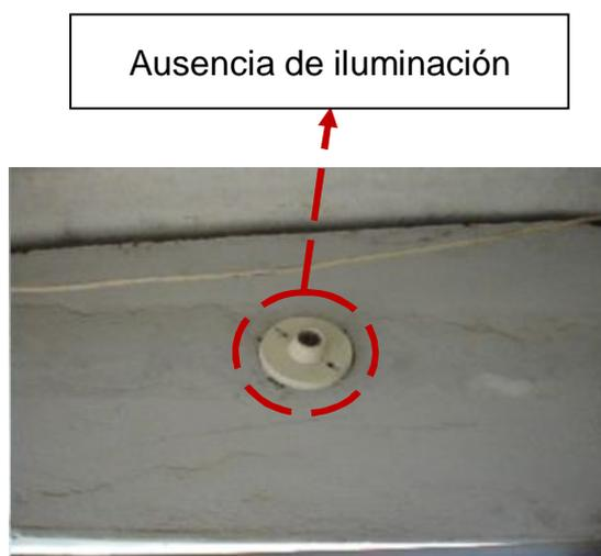
**Figura 3.6 Iluminación del cuarto de transformadores**
