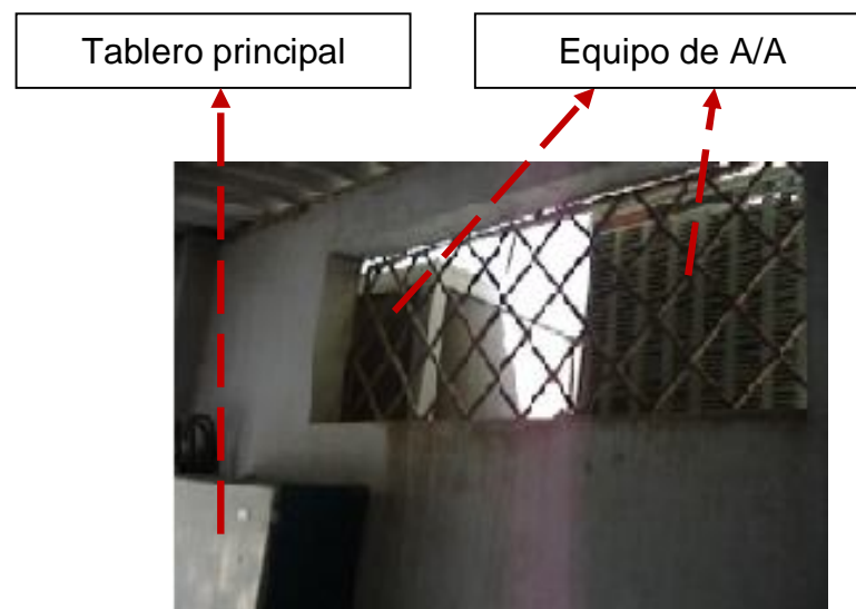
Figura 3.7 Ventilación para el área del tablero principal.
