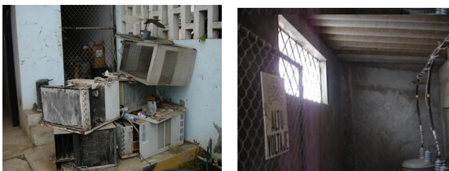
Figura 3.5 Ubicación del Banco de transformadores
