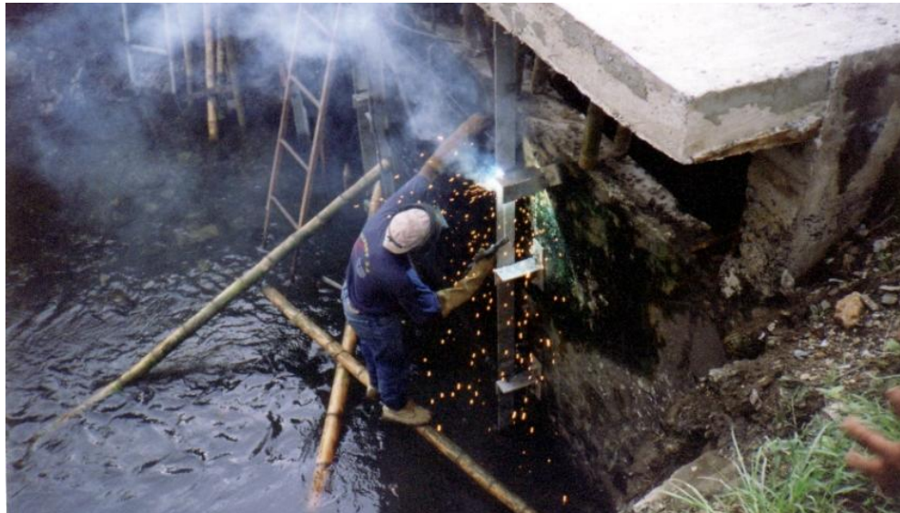
FIGURA 2.21 PROCESO DE REHABILITACIÓN EN MARCHA
