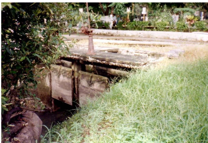
FIGURA 2.12 ESTADO DE ABANDONO DE LA COMPUERTA
