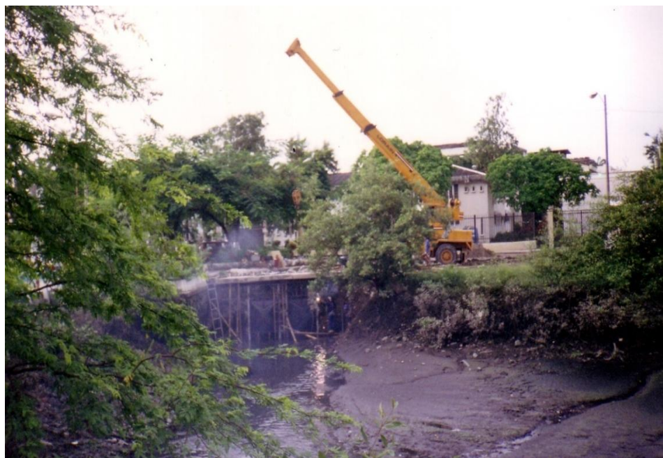
FIGURA 2.18 DESMONTAJE DE LAS COMPUERTAS
