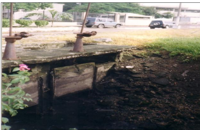
FIGURA 2.12 ESTADO DE ABANDONO DE LA COMPUERTA
