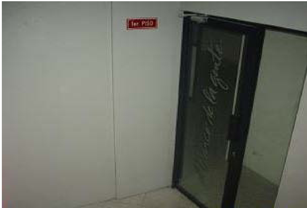
GRAFICO NO. 13 FOTOGRAFÍA DE LA PUERTA DE ENTRADA A LAS OFICINAS
