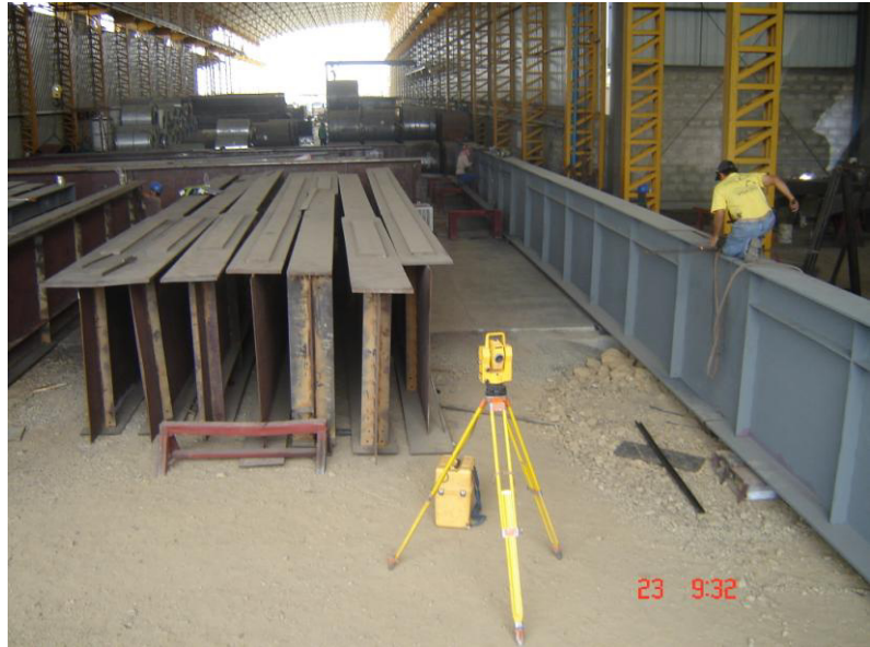
FIG. 3.7 COMPROBACION DEL CAMBER (Cortesía Intermetal)
