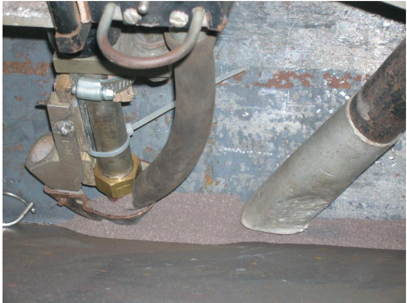
FIG. 2.8 SOLDADURA POR ARCO SUMERGIDO (Cortesía Intermetal)
