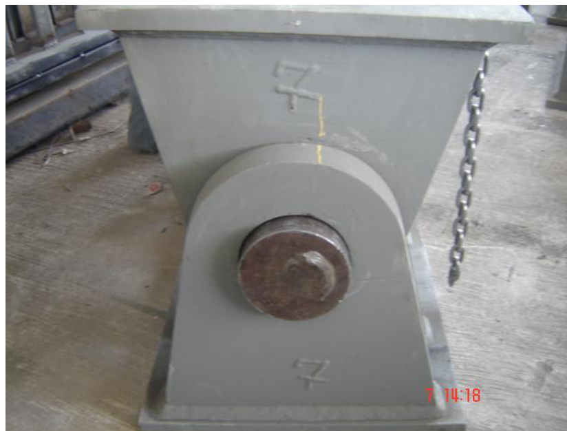
FIG 3.2 ARTICULACION DEL PUENTE (Cortesía Intermetal)
