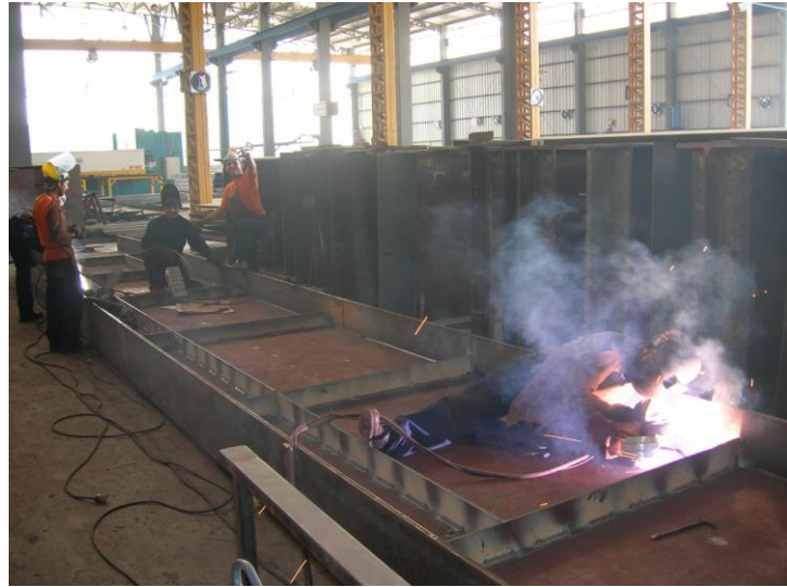
FIG. 3.6 COLOCACION DE LOS RIGIDIZADORES EN LAS VIGAS (Cortesía Intermetal)
