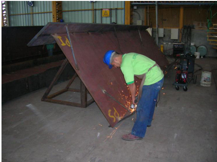
FIG. 3.5 PROCESO DE SOLDADURA DE LAS VIGAS (Cortesía Intermetal)
