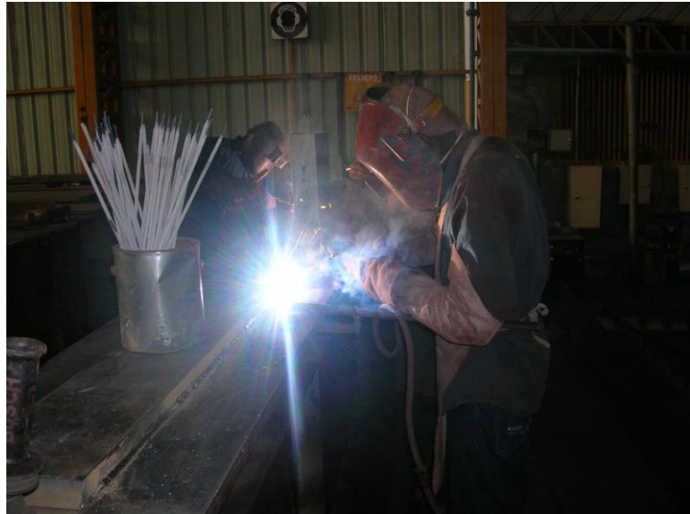
FIG 2.7 SOLDADURA DE ARCO CON ELECTRODO REVESTIDO (Cortesía Intermetal)
