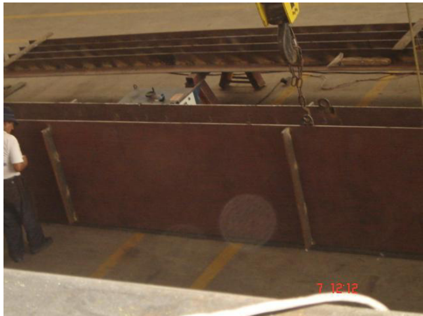
FIG 3.1 PROCESO DE ARMADO DE LOS TORNAPUNTAS (Cortesía Intermetal)
