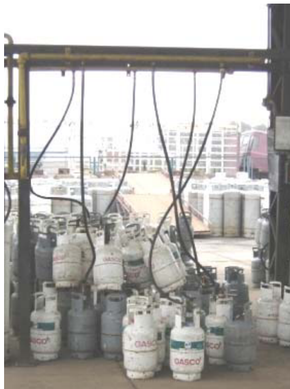
FIGURA 2.2 EXTRACCIÓN DE GLP VAPOR EN SISTEMA NO. 2.
