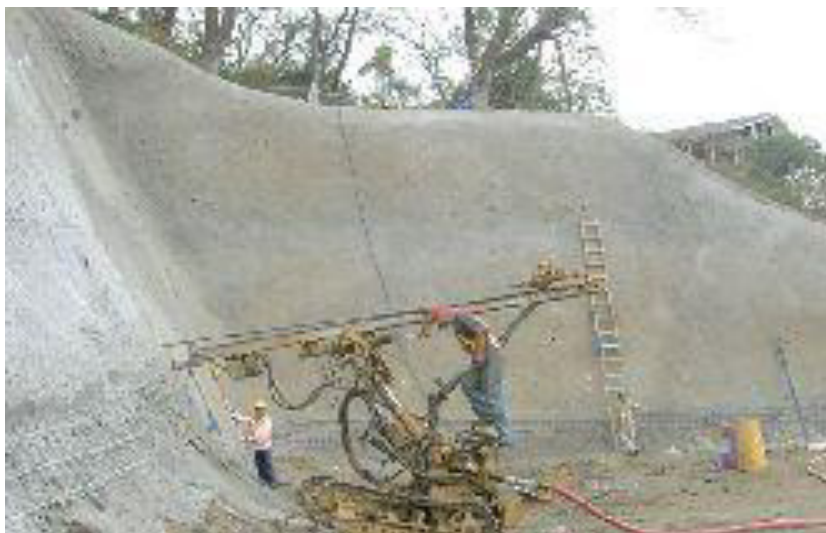
Fig.4.2 Estabilización de Taludes.
