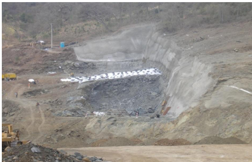
Fig. 4.15. Excavación por voladura – Portal sur.
