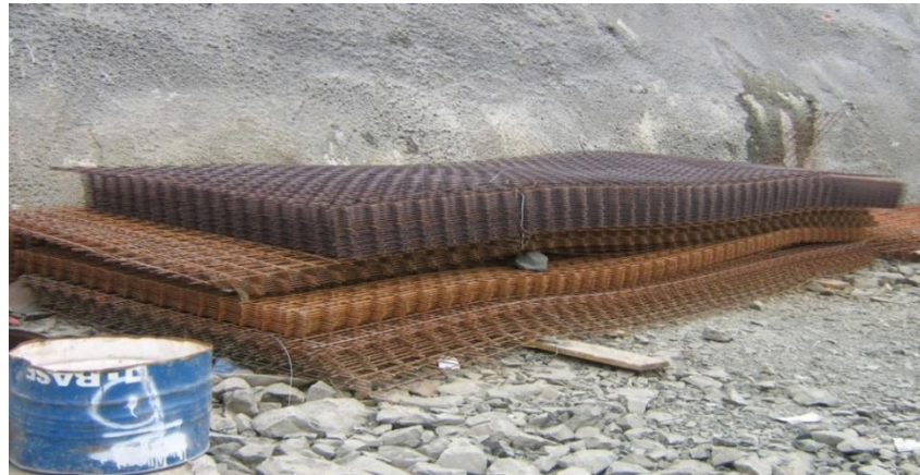
Figura 3.7. Mallas de acero.
