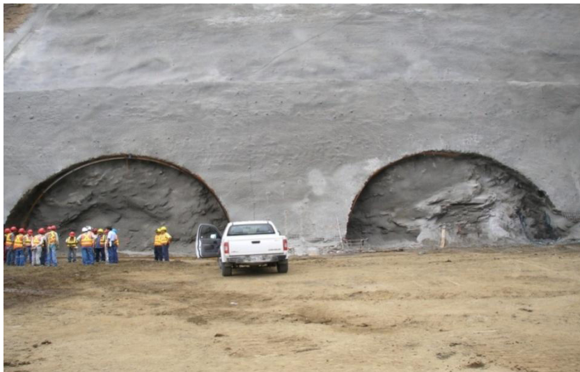
Fig.4.9. Excavación Inicial – Portal Norte
