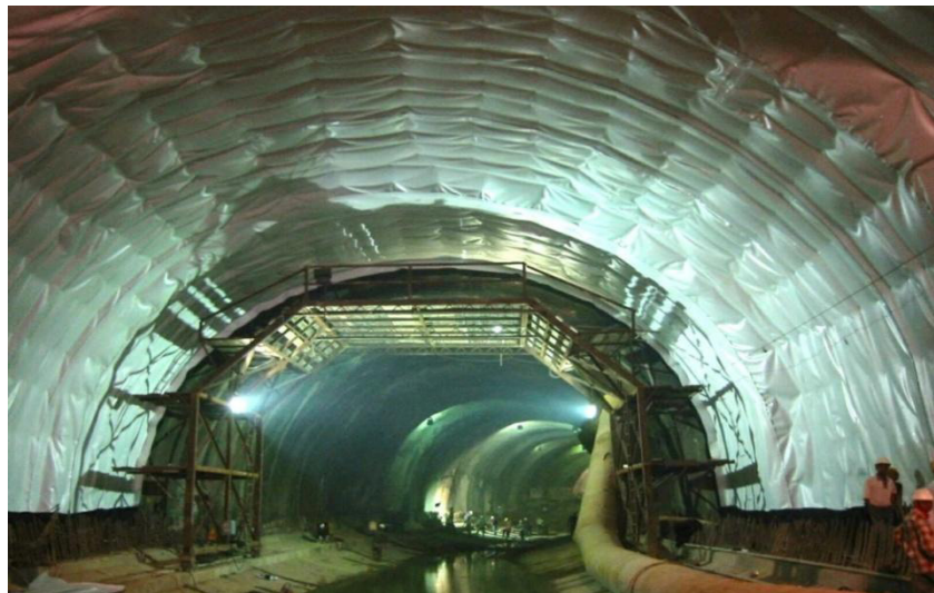
Figura 3.9. Impermeabilización del túnel.
