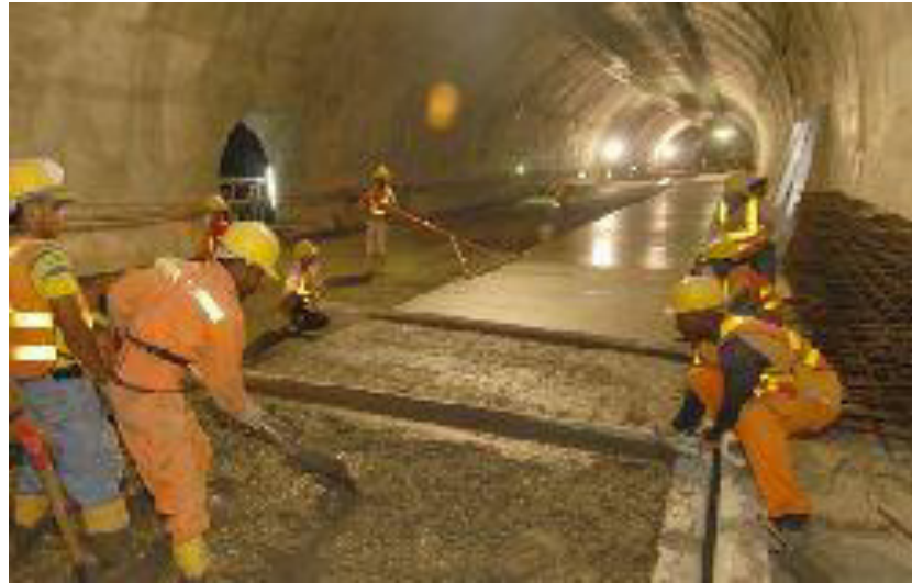
Figura 3.1. Colocación Hormigón Simple en la Vía.
