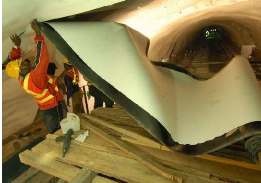
Figura 3.8. Colocación de membrana impermeable.
