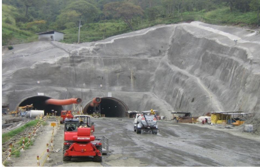
Fig.4.16. Sostenimiento de taludes- Portal Sur
