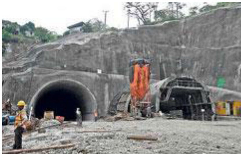
Figura 3.2. Elementos de hormigón armado en los accesos del túnel.
