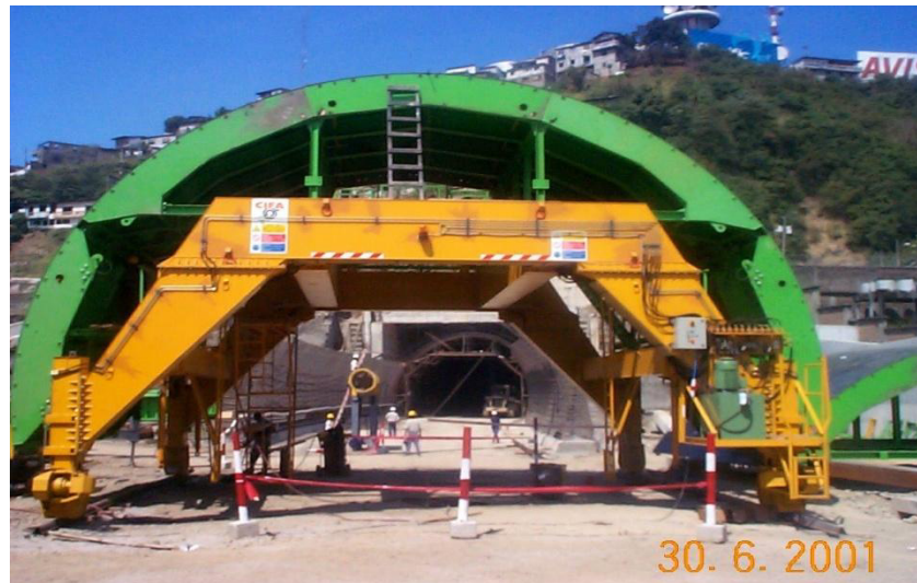
Figura 3.10. Encofrado del revestimiento del túnel.
