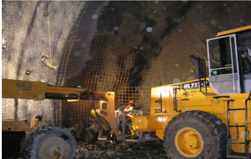
Figura 3.4. Colocación de Hormigón Proyectado en el revestimiento interior del túnel.
