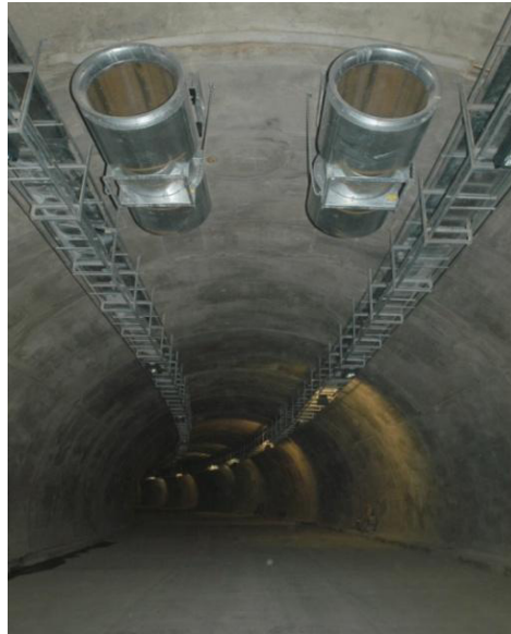
Figura 3.11. Colocación de sistema de ventilación.
