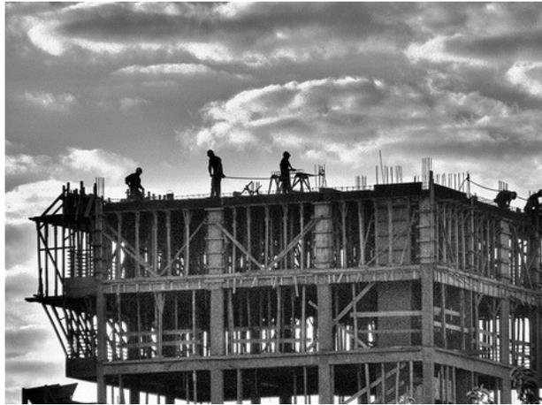
Fig. 3.11 Encofrado de madera tradicional
