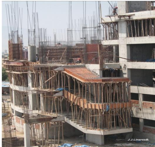
Fig. 3.4 Encofrado tradicional
