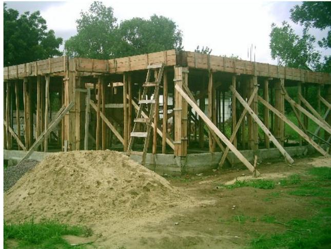
Fig. 3.3 Encofrado de madera
