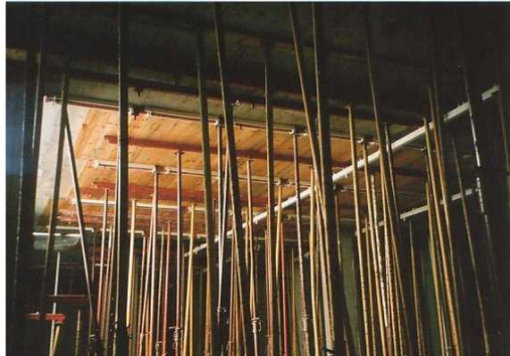
Fig. 2.2 Encofrado de losa
