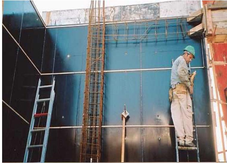
Fig. 3.2 Encofrado para hormigón visto
