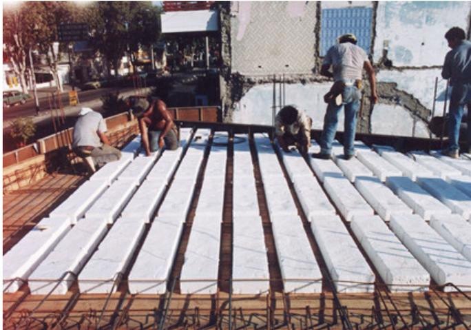
Fig. 3.7 Encofrado perdido
