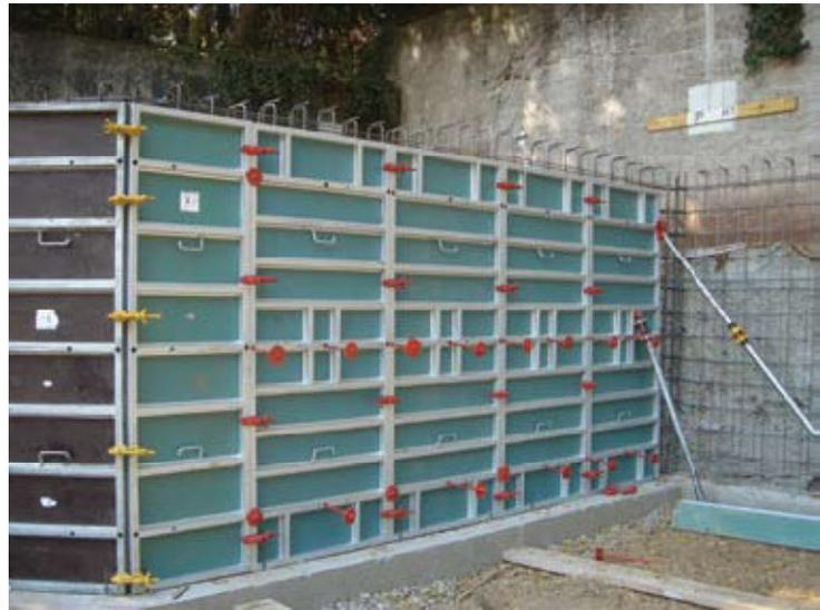
Fig. 3.13 Encofrados de plásticos
