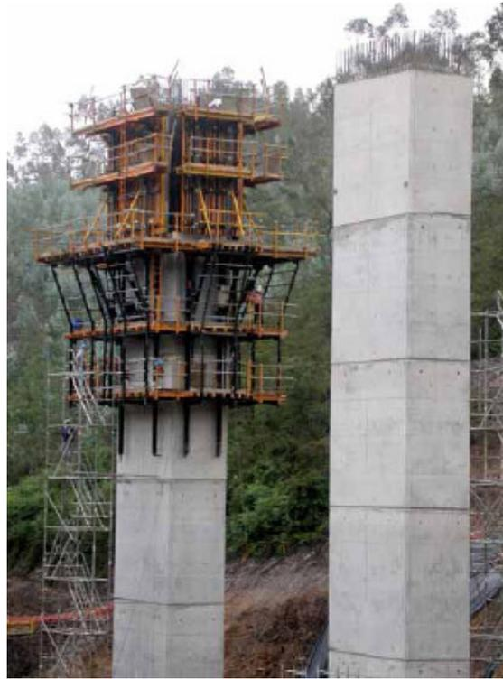
Fig. 3.9 Encofrado autotrepante
