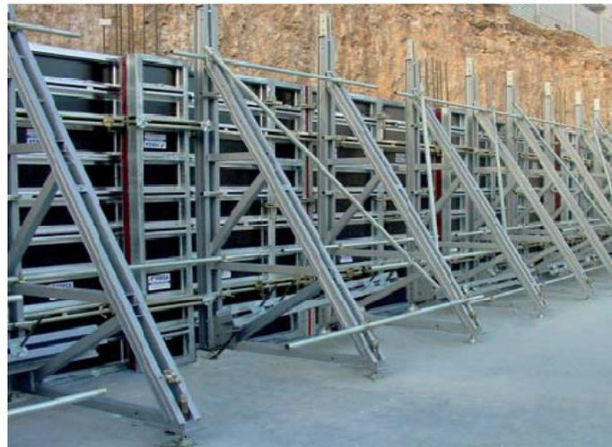
Fig. 3.12 Encofrado metálico
