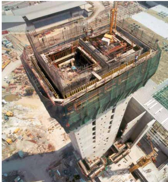
Fig. 3.8 Encofrado autotrepante
