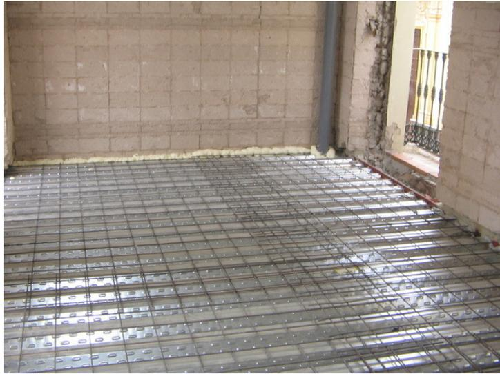
Fig. 3.6 Encofrado perdido
