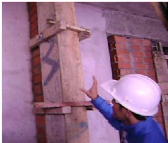
Fig. 2.1 Encofrado en columna.
