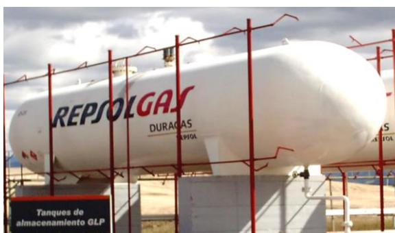
**FIGURA 2.6. TANQUE DE ALMACENAMIENTO DE GLP**
