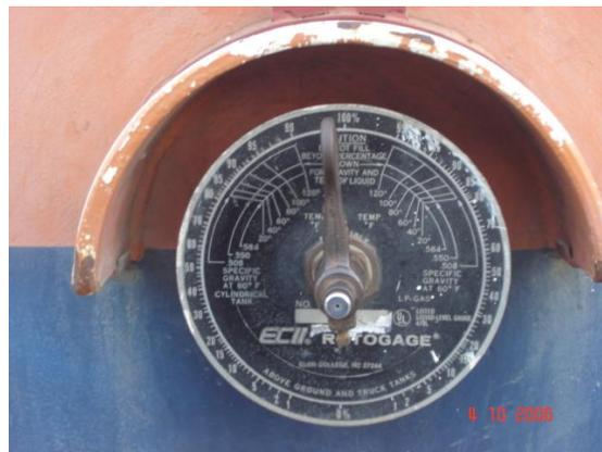
**FIGURA 3.2 VISTA EXTERIOR DE UN DISPOSITIVO DE MEDICIÓN DE NIVEL DE LLENADO TIPO GALGA ROTATIVA (ROTOGAGE)**
