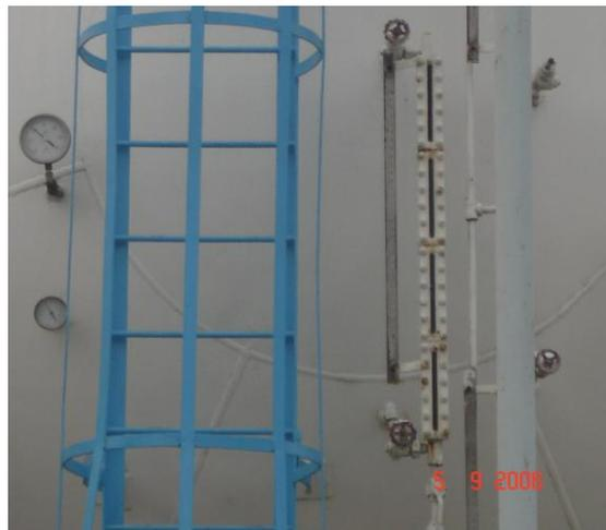
**FIGURA 3.10 SONDA DE VISUALIZACIÓN DE NIVEL DE LÍQUIDO EN TANQUES PCO**
