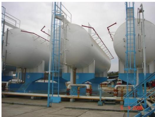
**FIGURA 2.7 TANQUES DE TERMINAL DE GLP SALITRAL ASIGNADOS PARA EL BOMBEO A LA PLANTA ENVASADORA**
