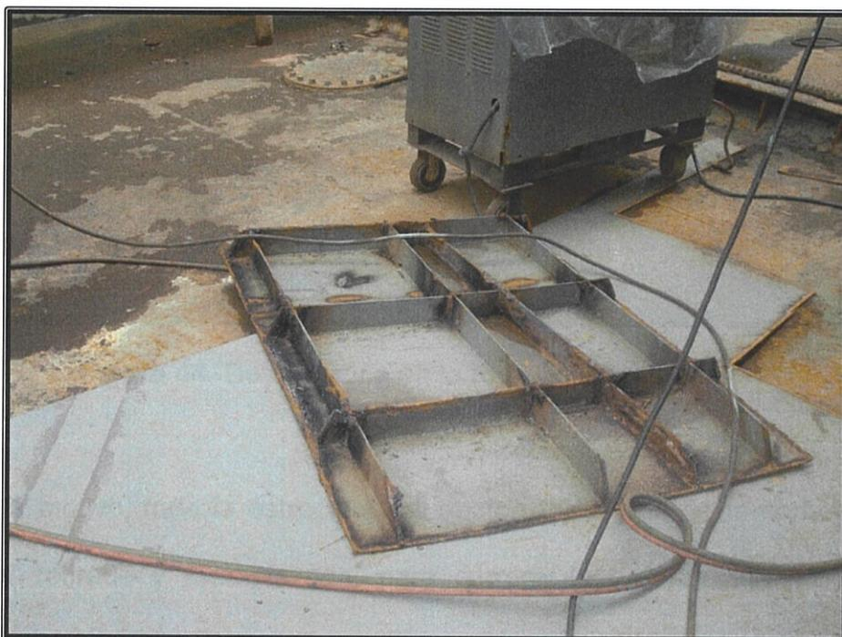
**Figura 43.** Planchaje nuevo a ser instalado en la embarcación, [1]
