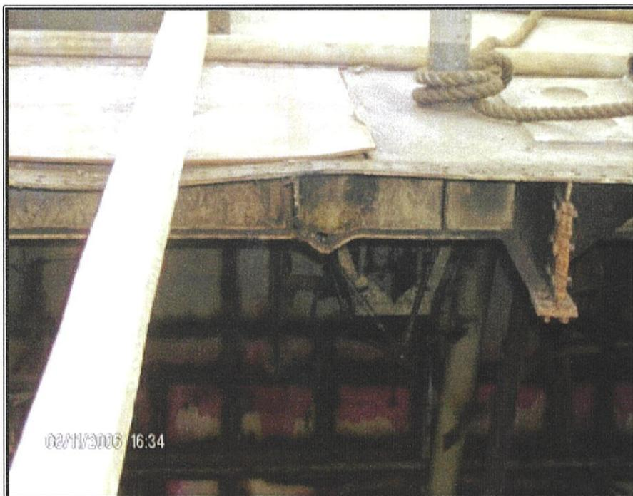
**Figura 46.** Deformación permanente registrada en un refuerzo primario, [1]
