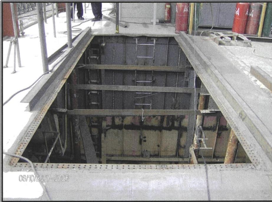
**Figura 37.** Desmontaje de las tapas de registro, [1]
