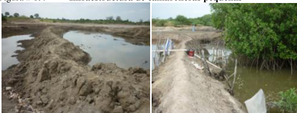
Figura # 19. Infraestructura de camaroneras pequeñas
