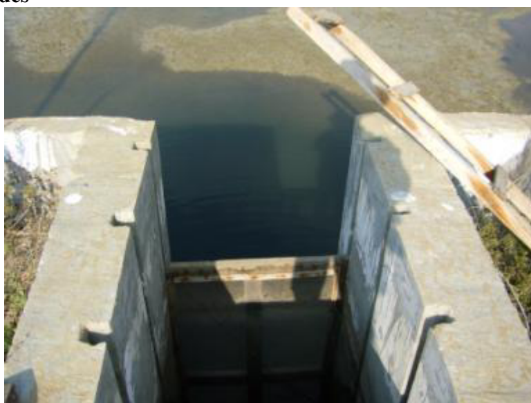
Figura # 21. Preparación de compuertas en camaroneras medianas y grandes
