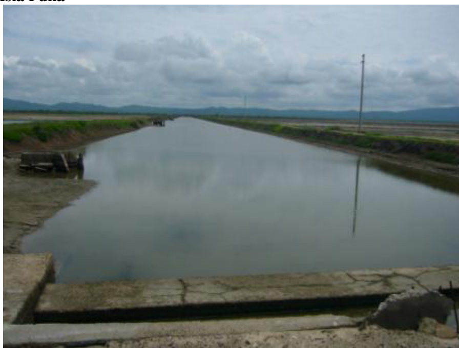
Figura # 18. Infraestructura de camaroneras grandes y medianas de la Isla Puná
