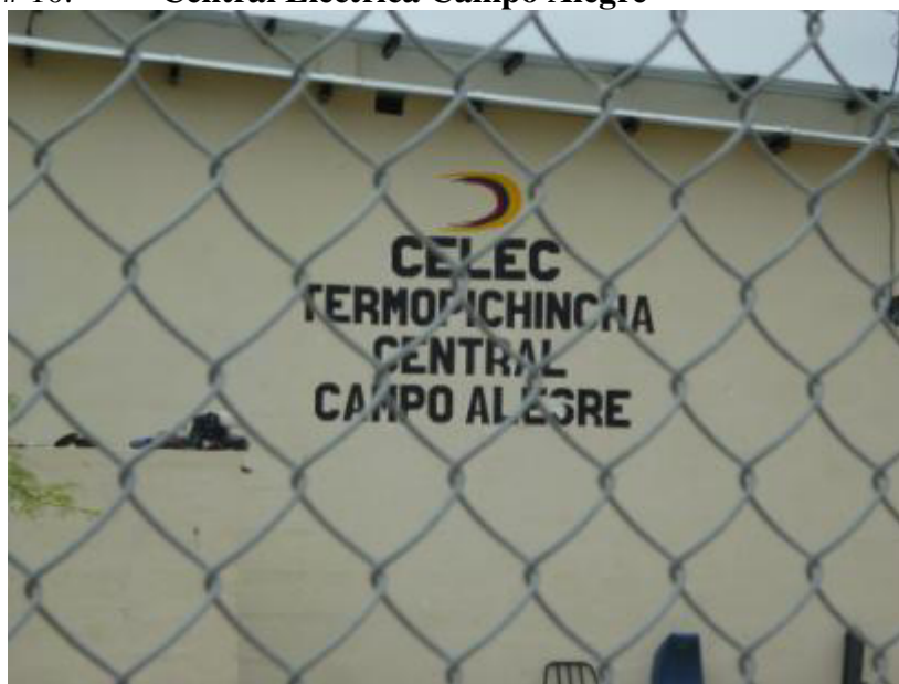
Figura # 10. Central Eléctrica Campo Alegre
