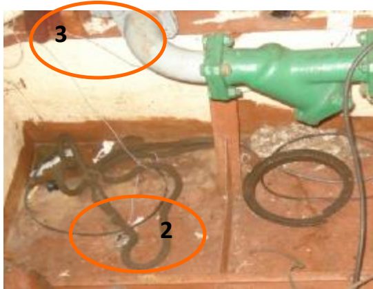
Foto No. 5. a: Extensómetros 2 y 3. Plancha del fondo y ala de la Quilla.
