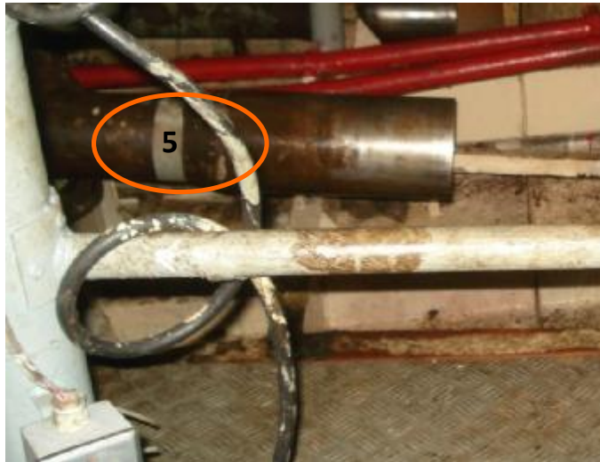
Foto No. 3: Extensómetro 5. Sobre el eje intermedio
