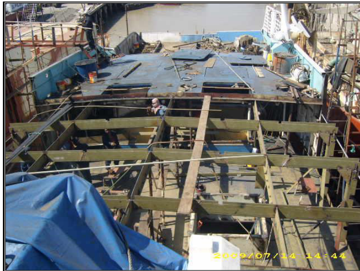
Figura 11.A.- Baos de la cubierta superior en el parque de pesca.
