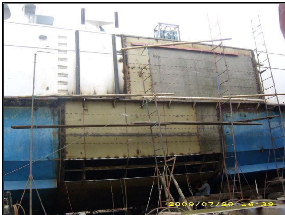
Figura 9.B.- Sector donde se insertó el bloque de 7.0 m, [1].
