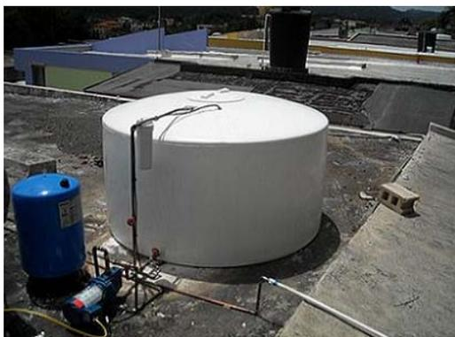
Figura No. 2.17. Cisterna es utilizado como un depósito para almacenar y distribuir agua.
