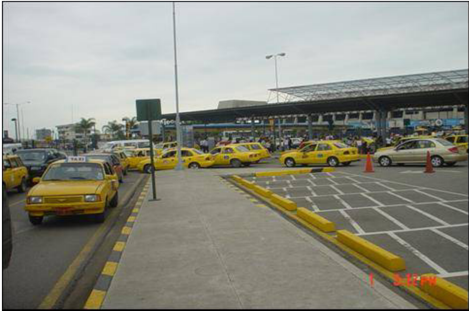
FIGURA 3.15 ESPACIOS PARA PARQUEO DE LA TERMINAL TERRESTRE
