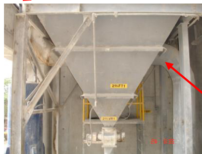
FIGURA 4.3. ENTRADA DE DUCTOS EN SENTIDO OPUESTO
