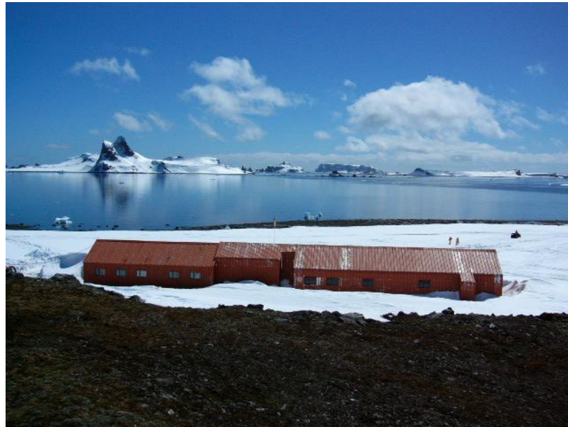
FIGURA 4.1. FOTOGRAFÍA DE LA ESTACIÓN FACHADA POSTERIOR
