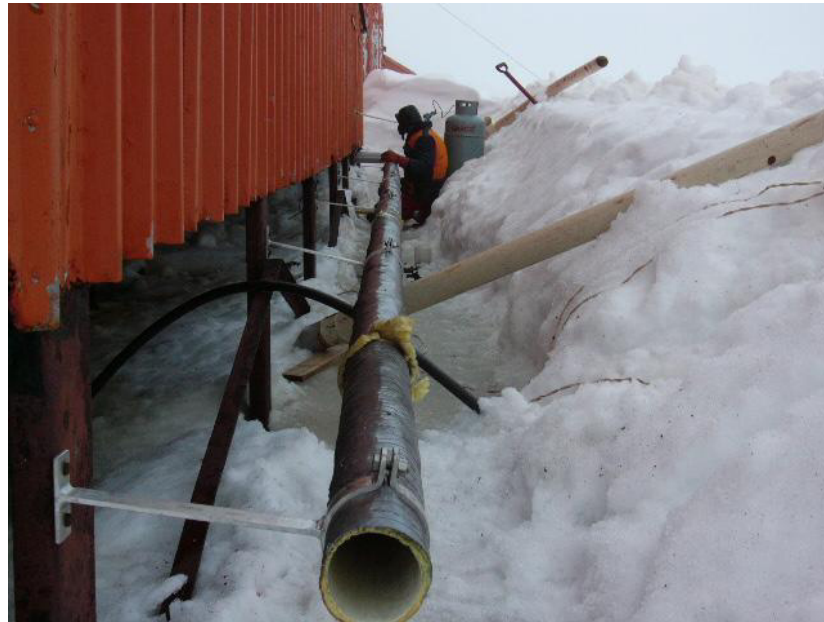
FIGURA 4.2. PARED POSTERIOR DE LA ESTACIÓN
