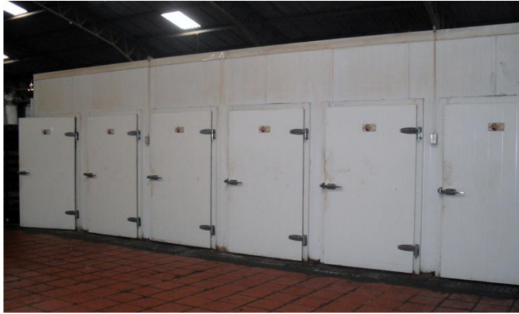
FIGURA 2.15 FOTO CÁMARA DE FERMENTACIÓN
