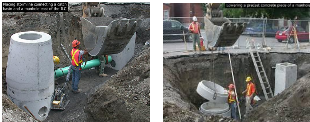
Figura 1.5 Manhole elaborado con hormigón prefabricado.
