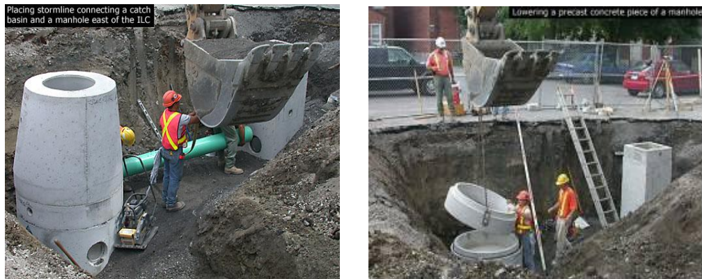
Figura 1.5 Manhole elaborado con hormigón prefabricado.
