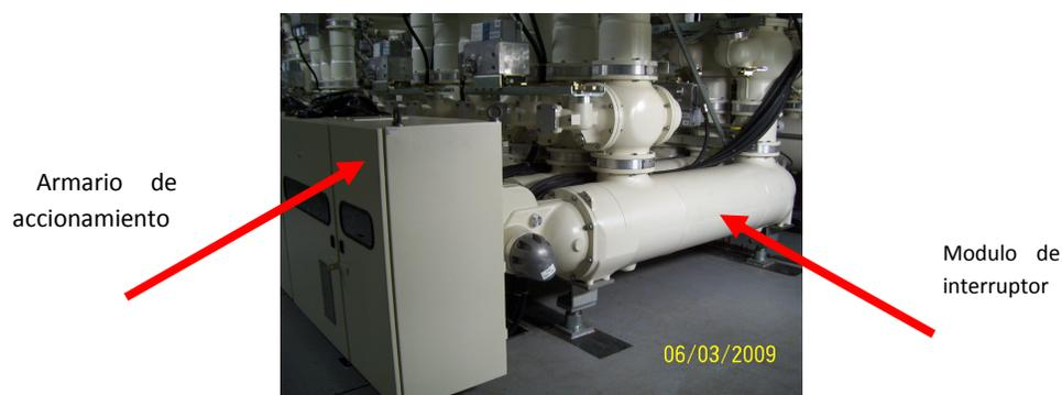
**Fig. 8. Interruptor de potencia**
