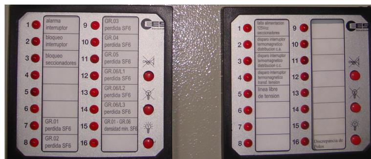
**Fig 30. Panel de alarmas del Nivel Cero**
