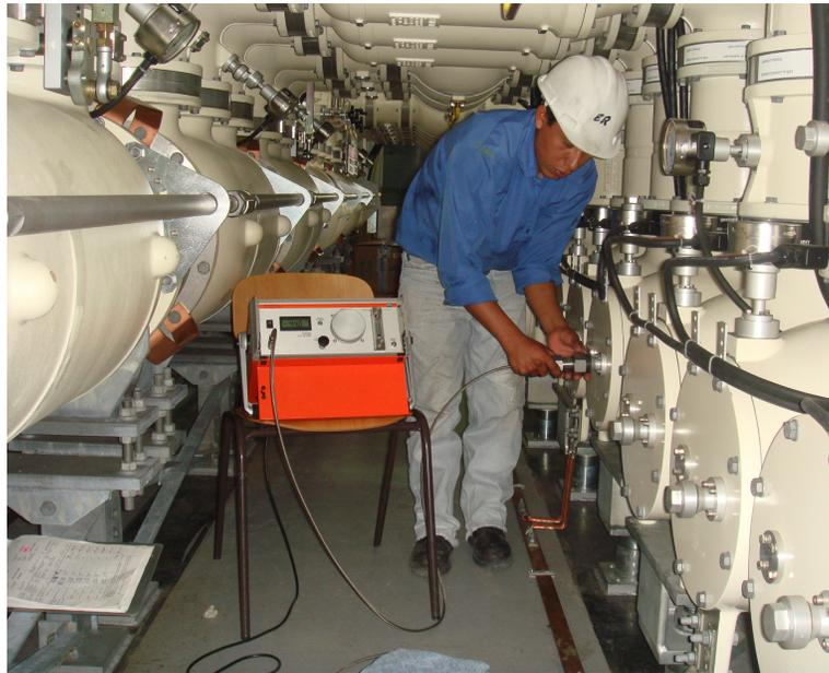
**Fig 29. Equipo de medición de punto de rocío.**
