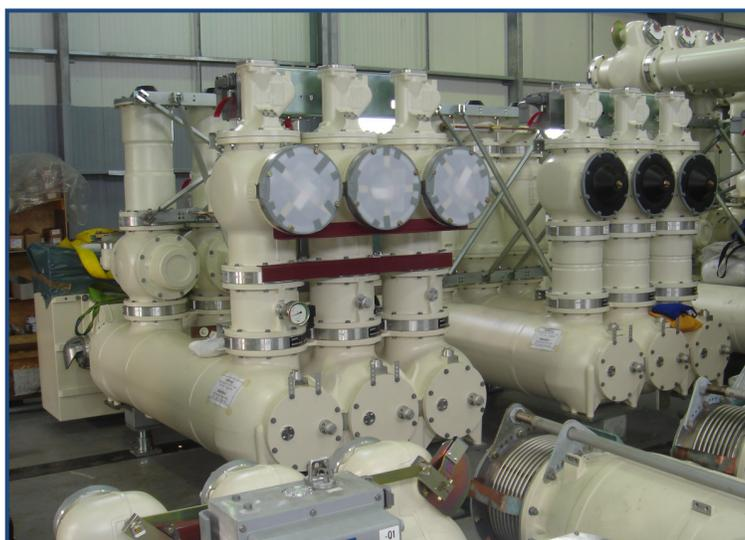
**Fig 14. Modulo de bahía colocada en sitio de montaje**
