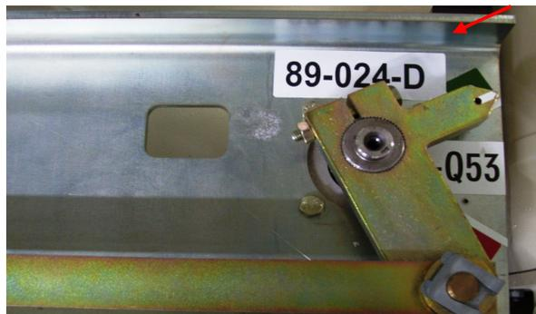
**Fig 27. Indicador óptico ABIERTO/CERRADO**
