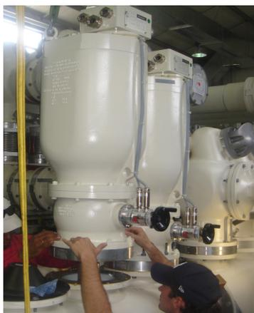
**Fig. 11. Transformador de Potencial**
