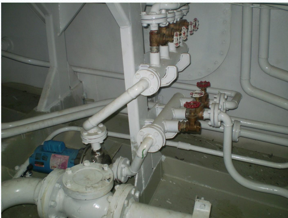
Figura No. 41. Sistema de intercambio de diesel
