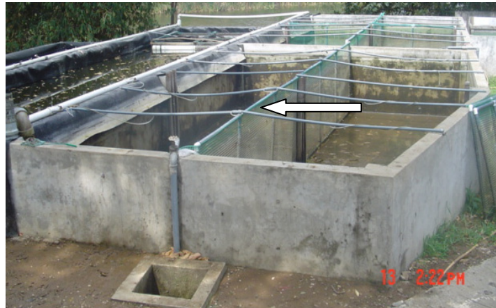
Figura 6. Estructura longitudinal construida en el interior de los tanques 1 y 2
