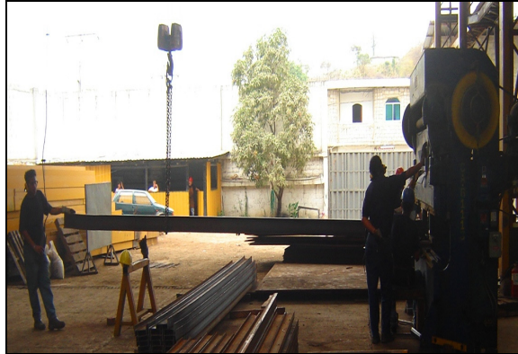
FIGURA 3.4 PRE-CURVADO DE VIGAS
