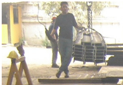
FIGURA 3.2 TRASLADO DE LAS VIGAS
