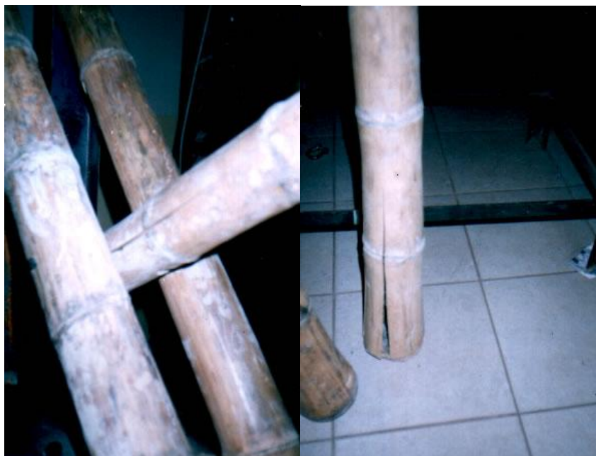
Figura 2.10 Falla de la caña longitudinalmente
