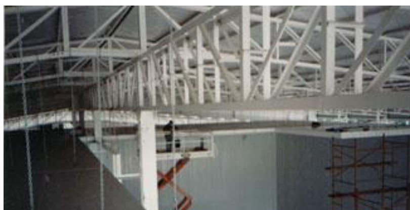
FIGURA 2. 2 ESTRUCTURA DEL TECHO DE LA CÁMARA.
