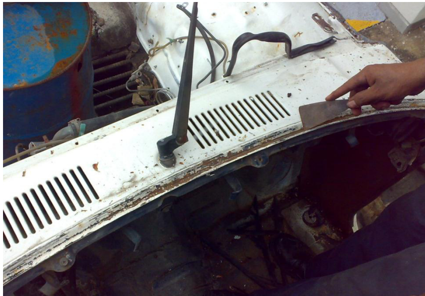
5-3 LIMPIEZA DE PARTES CORROÍDAS
