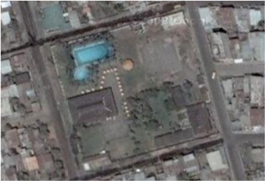
Figura 36: Vista aérea de las instalaciones (Latitud : 2° 8'1.46"S; Longitud : 79°36'3.53"W)
