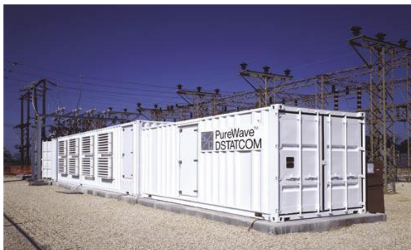
FIGURA 1.16 Foto de un DSTATCOM de marca PureWave
